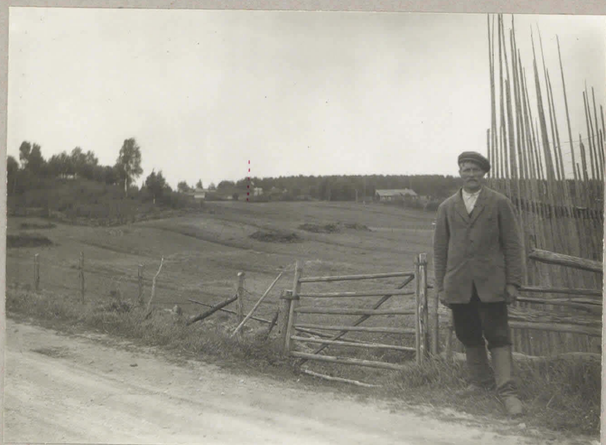
7838 Askola, Vanijärven kl. Siitälä. Kivikk. as. p. niiden kohdalla.
