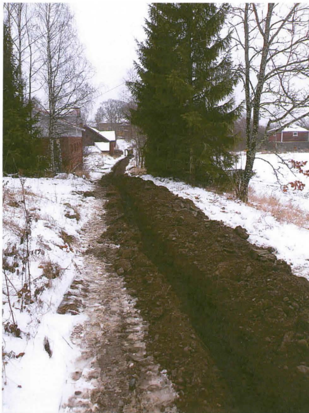
Kuva 001. Valvonnassa kaivettua maakaapeliuojaa Hennerin tilan pihatiellä. Itään.
