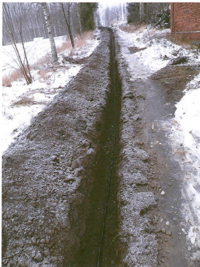
Kuva 012. Valvonnassa kaivettua maakaapeliotjaa Hennerin tilan pihatiellä. Länteen.
