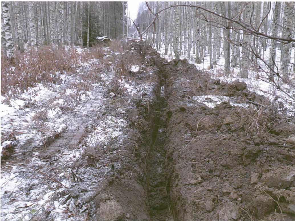
Kuva 017. Hauralantien länsipuolista maakaapeliotjaa. Etelään.
