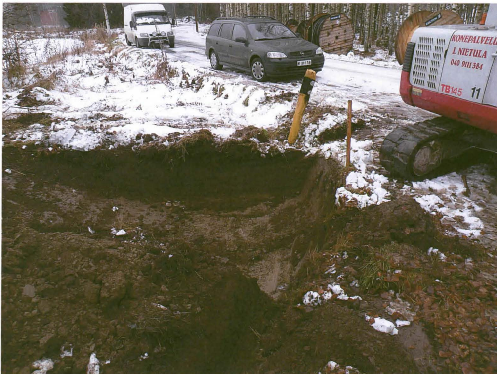
Kuva 4. Suuntoporauskaivanto Hauralantien itäpuolella. Lounaaseen.
