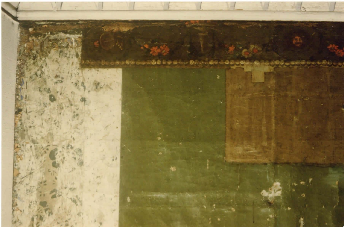
IV SÄNGKAMMARE pohjoisseinän kangastapetille maalatut kerrokset paperitapettien poistamisen jälkeen. Vasemmalla sabloonalla liimamaalille maalattu koristeaihe, seuraavana vihreä empire-kerros. Ylhäällä myöhäiskustavilainen koriste ja sen alapuolella ruskealla lakalla päällemaalattu vihertävän harmaa öljymaali, joka näkyy pienessä koeruudussa. Kaikkia kerrostumia jätetään esille.
