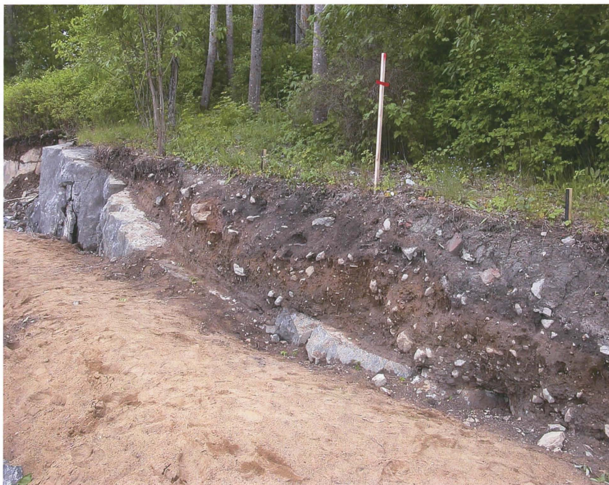
Partolan historiallinen kylätontti kesäkuussa 2010: kevyen liikenteen väylän perustuksia tehtäessä syntynyt maaleikkaus, jossa erottuu kulttuurimaata ruskean savensekaisen maan päällä. Kuvaussuunta kaakko. Kuvaaja: Sami Raninen
