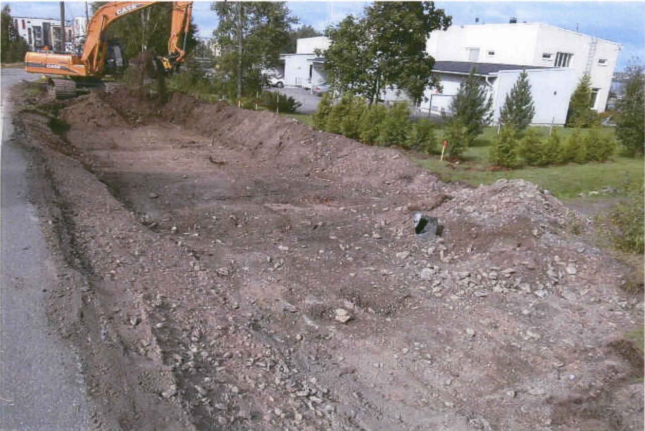
Kuva 11: Pereentien pohjoispuolista kaivantoa. Kuvattu luoteeseen. Kuvaaja: Sami Raninen
