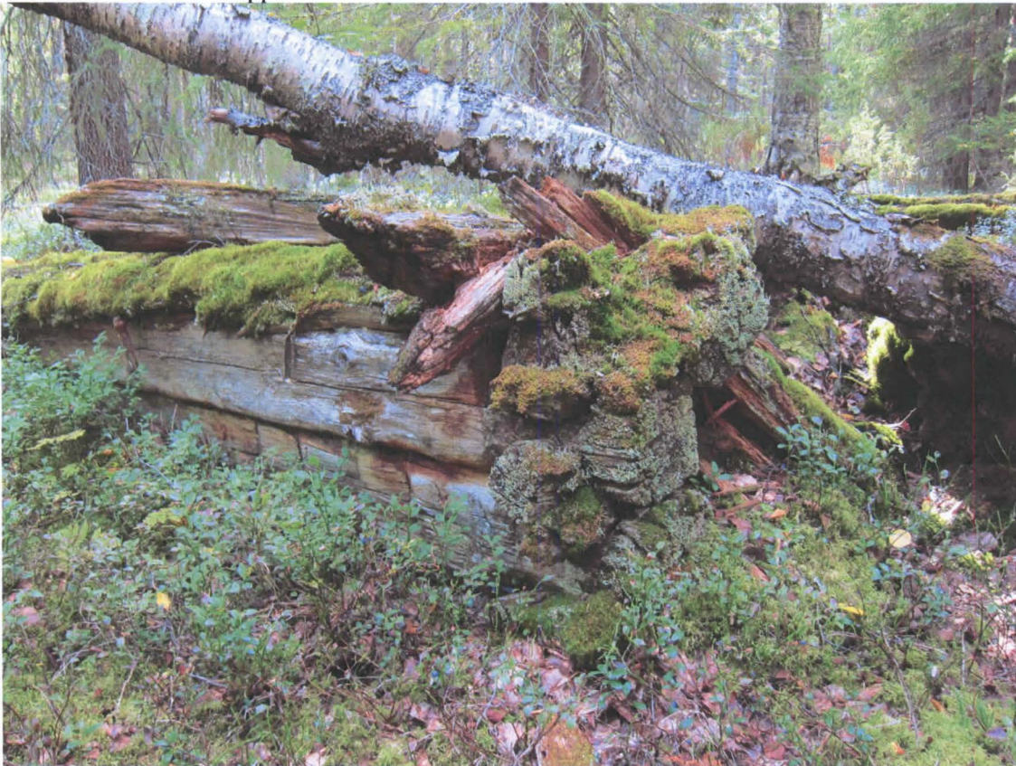
Kohde 5. Hirret salvottu koirankaulalla. Hirsien pää sahattu, päällimmäisissä kirveen jälkiä. Kuva LKYO/Sirkka-Liisa Seppälä.
