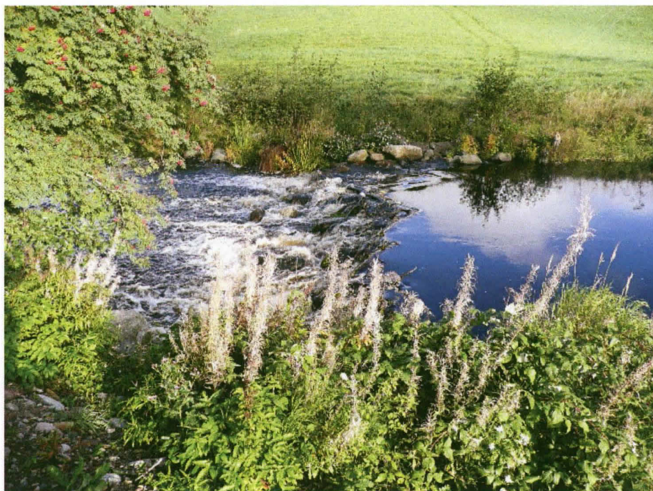
Kuva 7. Jyräsen kohteen kunnostettu pato kuvattuna joen etelärannalta.
