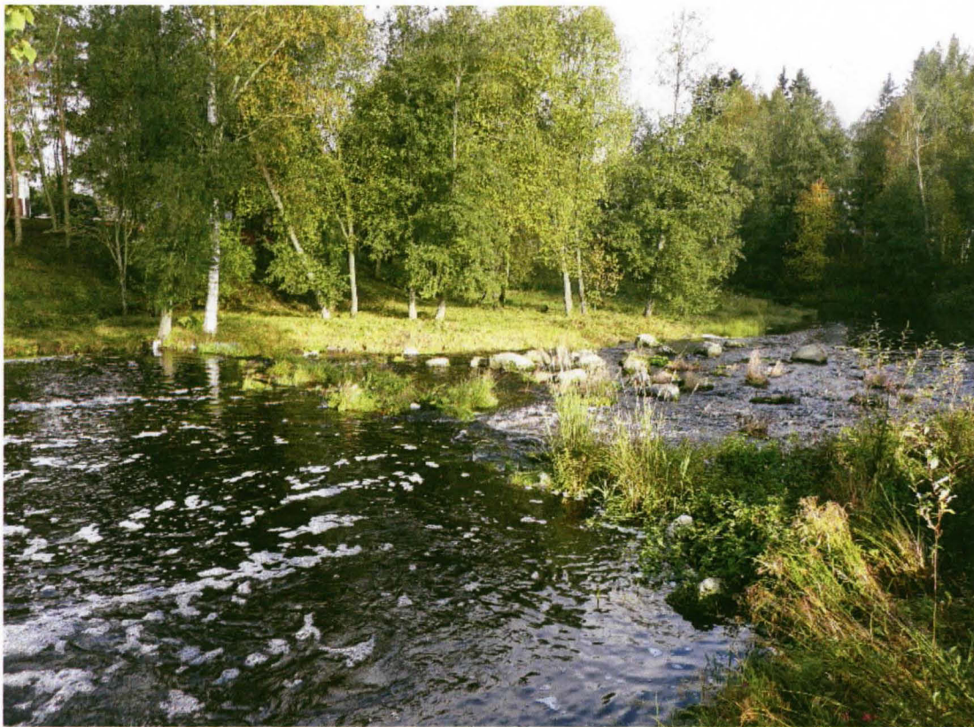
Kuva 10. Kosken kohteen hajonnut kivipato. Kuva kaakosta.
