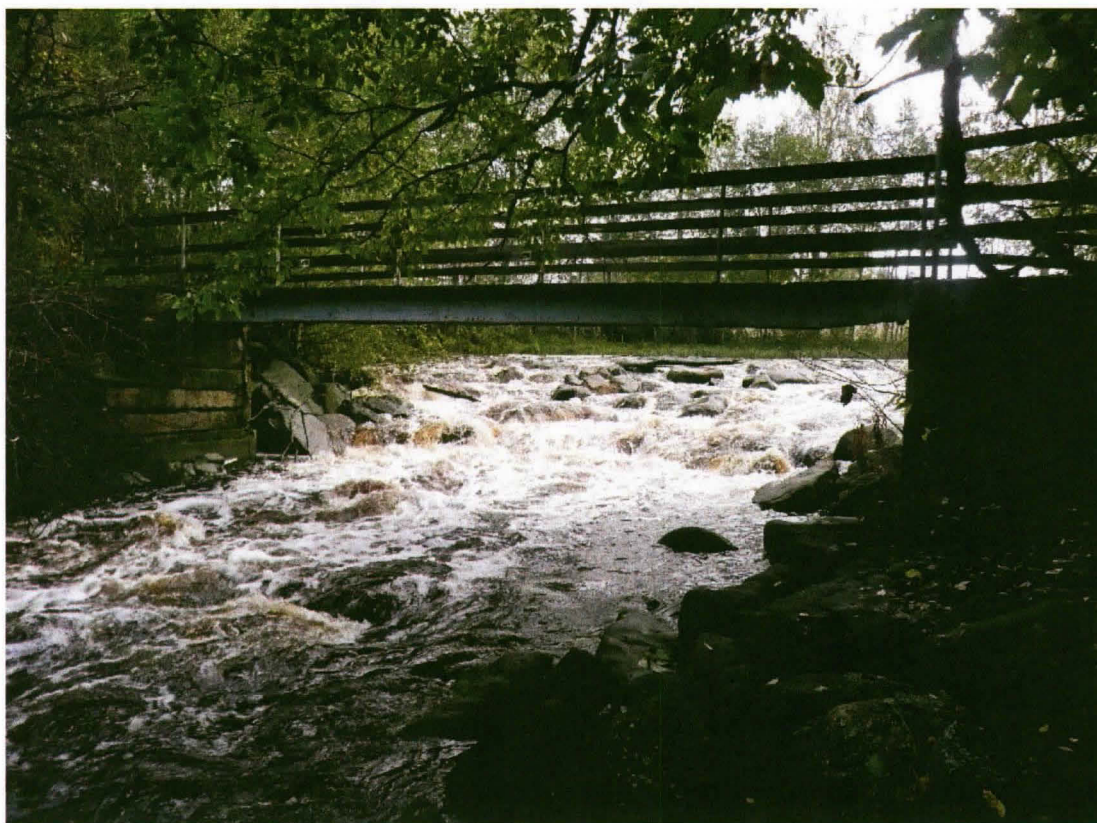
Kuva 8. Kunnostettu pato Ikkelänjoessa Koskelan kohteessa. Kuva lounaasta.
