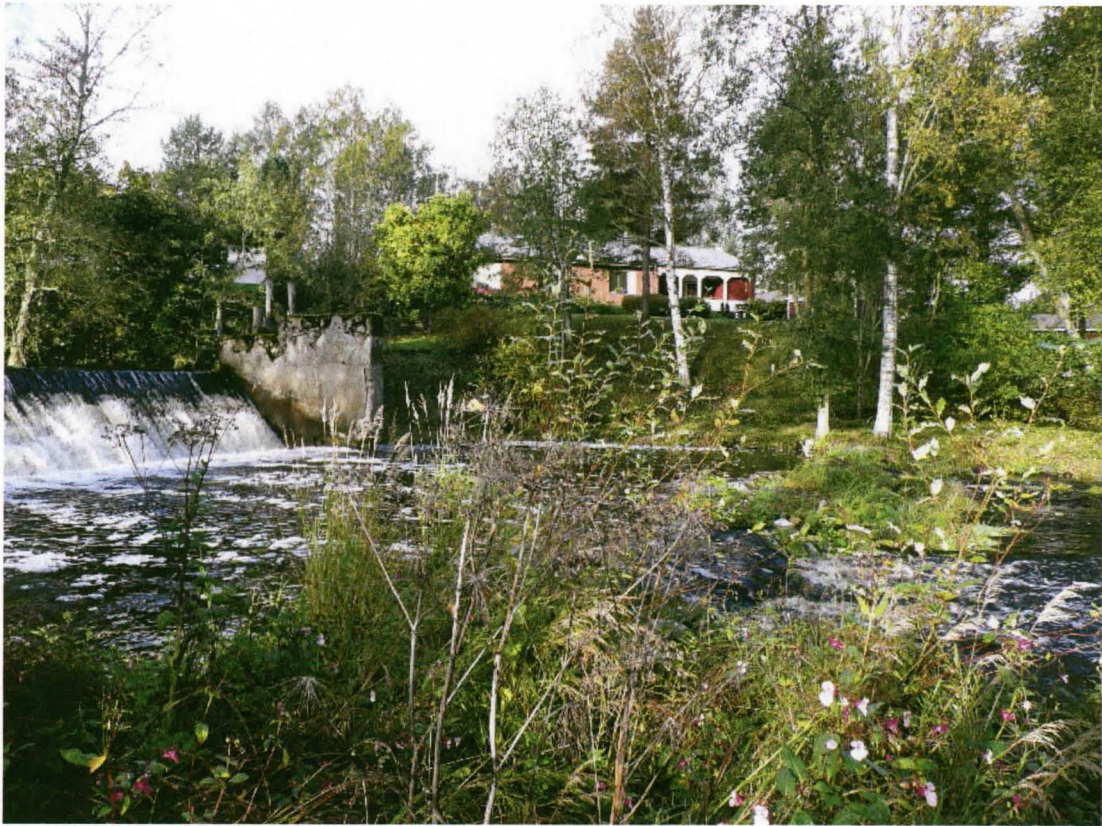
Kuva 9. Kosken kohteen betonipato ja kivipadon jäänteitä sen pohjoispuolella. Kuva idästä.
