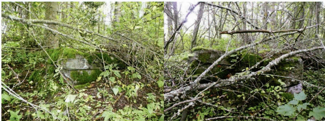
Kuvat 32-33. Rakennuksen perustaan liittyviä rakenteita.
