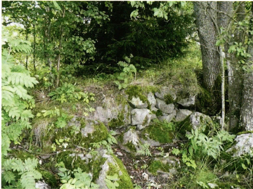
Kuva 19. Myllyn perustan jäänteitä joen keskikohtalla sijaitsevassa saarella.
