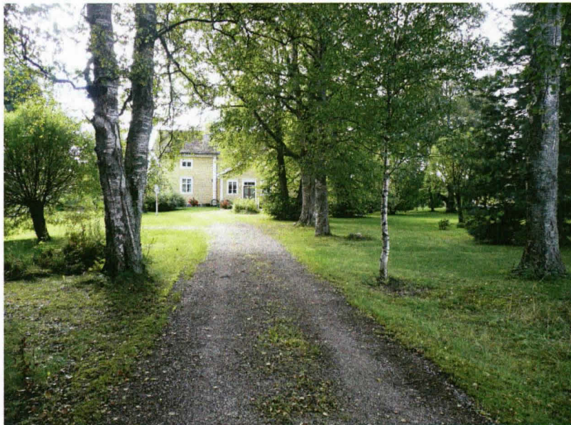
Kuva 15. Kuva koillisesta Varpolan kohteeseen.
