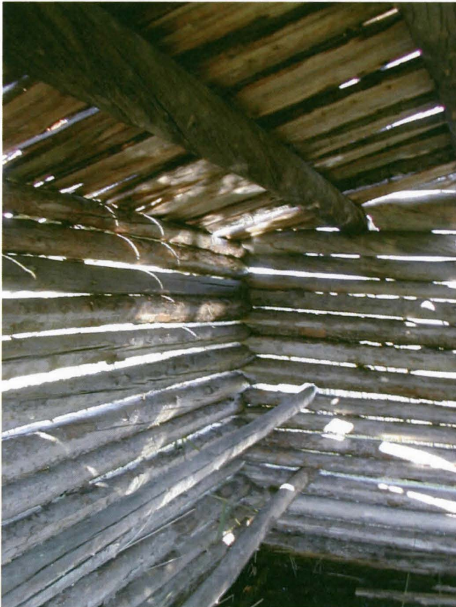
Rytisuo 2 nüttylato, 47468, pisteessä 7368187, 3603577. Sisätiloja. Reiska väittää ladon rakennetun vuonna 1970. Paremminkin vaikuttaisi siltä, että latoa olisi ekkä tuolloin korjailtu. Muun muassa kurkibirret vaikuttavat jälkikäteen vaihdetuilta. Pikanttina yksityiskohtana ladon sisällä tukipuut, joita oli molemmilla seinustoilla. Kuvattu 24.7.2009.
