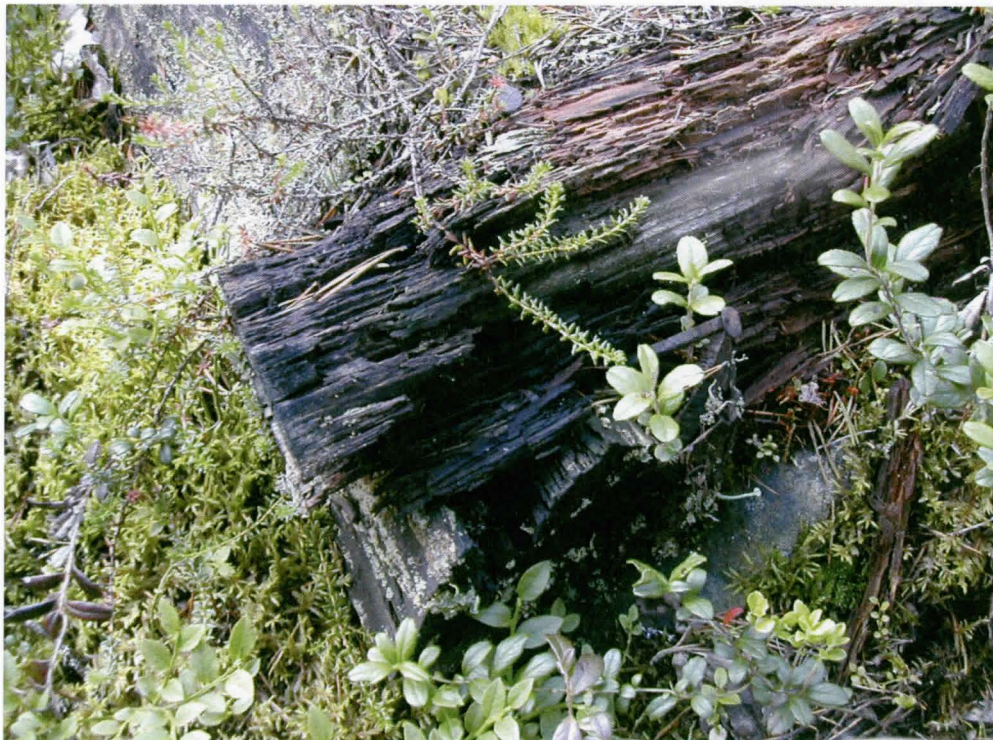
Alla: Tulilampi W 47449, "tupasija 1030", rakennuksen nurkkaa pisteessä 7366277, 3610558. Hirsien käsittelystä päätellen ei rakennus voi olla kovin vanha. Kuvattu 22.7.2009.
