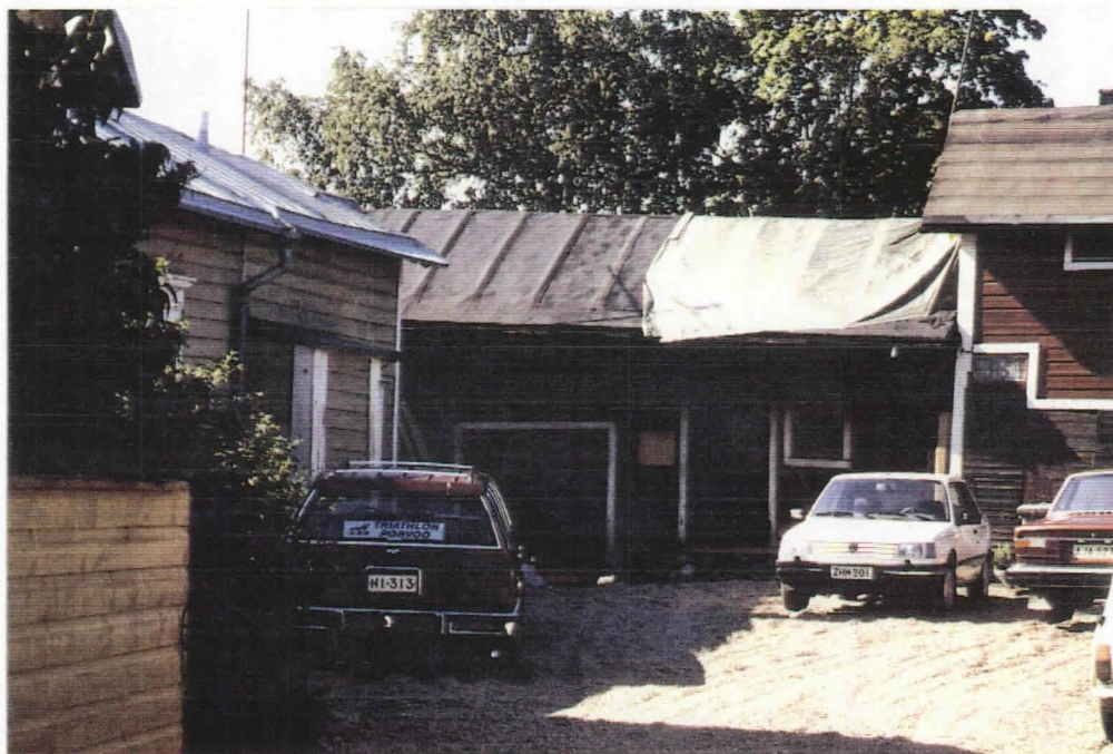
Aitan rungon oikaisu on suoritettu. Vesikaton korjaustyö ovat alkamassa.
