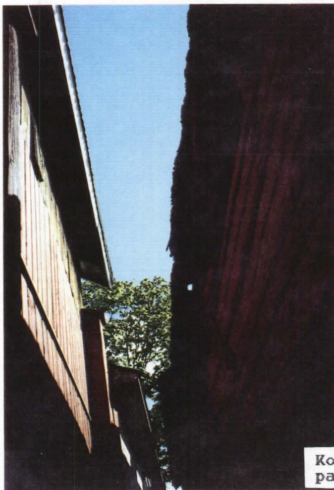
Korjattua palosolaosuutta 1988-90 Tarna & Silander.
