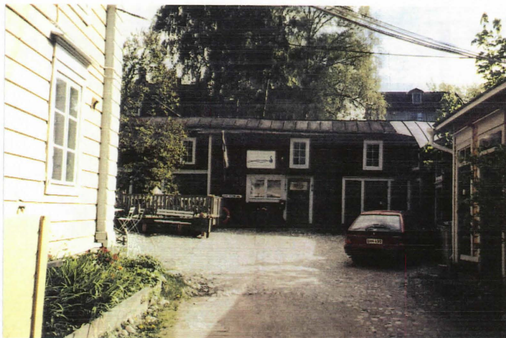
Pihanäkymä korjattavasta käsi- työtalosta, Välikatu 7
