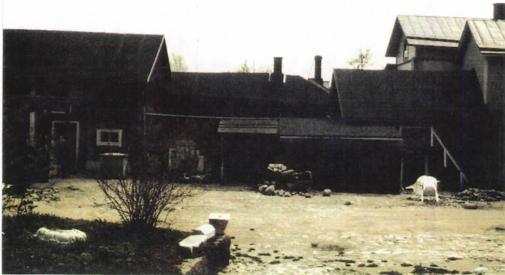
Korjatut vesikatteet, kohde Tarna&Silander, Kirkkokatu 13
