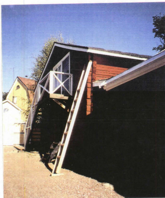
Aitan puu- ja maalaustöiden viimeistely käynnissä.
