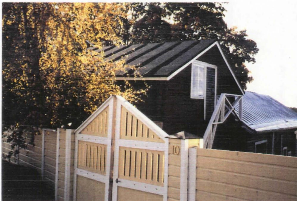
Aitta korjattuna nähtynä suuremmalta Kirkkotorilta.
