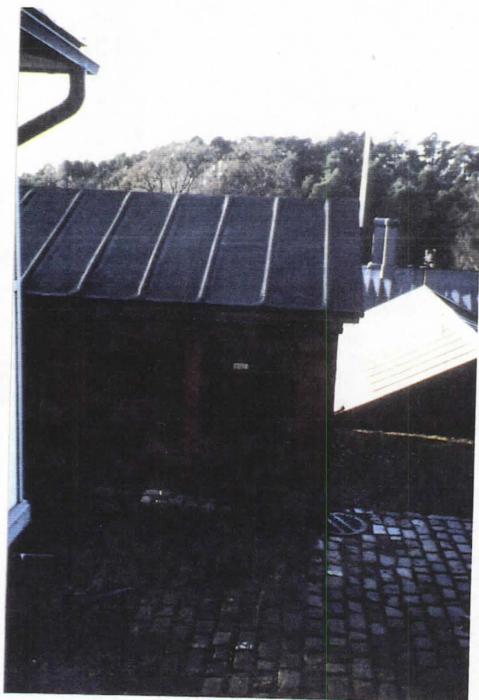
Aitta pihanpuolelta korjattuna.
