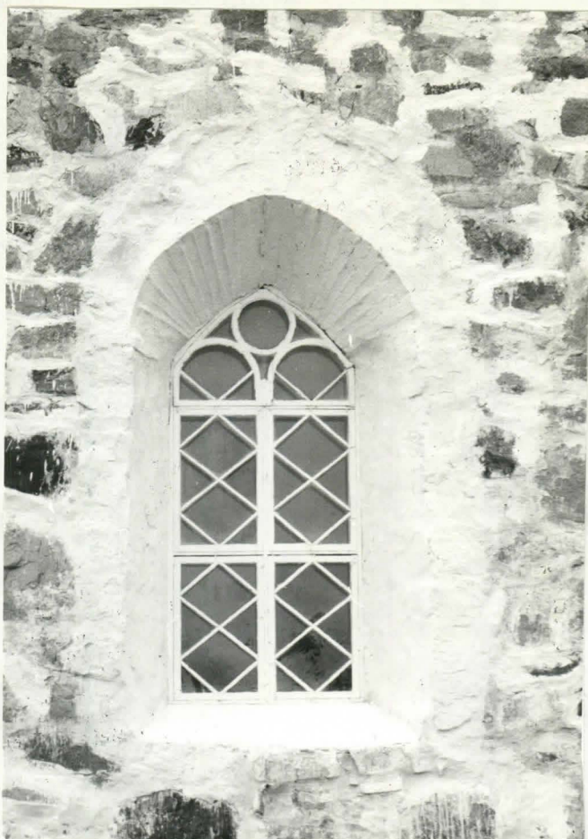
Fig. 6 Östra fönstret från utsidan Foto: A-C. Granholm
