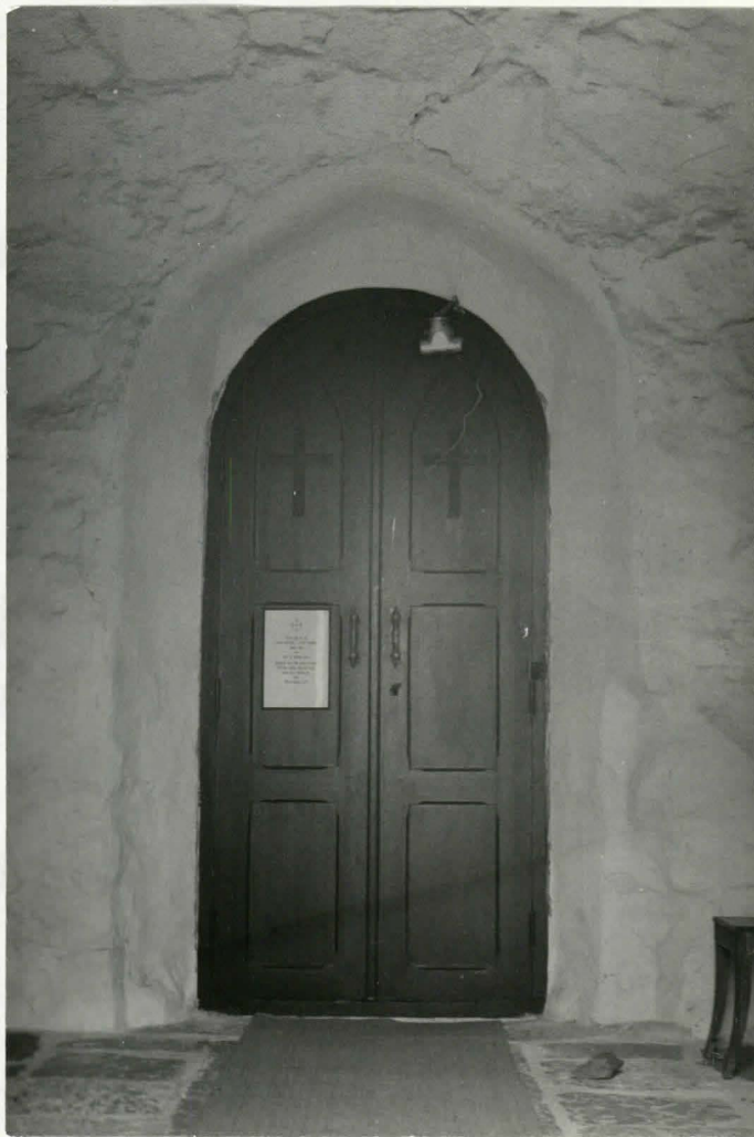
Fig. 7 Inre portalen sedd från vapenhuset Foto: A-C. Granholm
