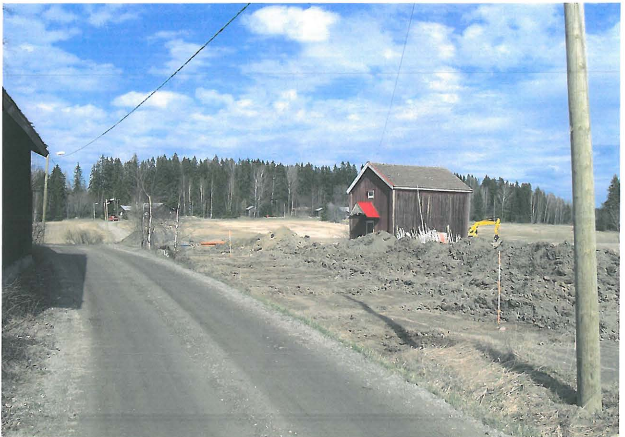
DSCN9692.JPG Valvonta-alueen NE-osa, kaivannon keskiosa (risteyksen SE-puoleinen alue), linjakepit ovat palomaaläikkien 3 ja 2 kohdalla. Lounaasta.
