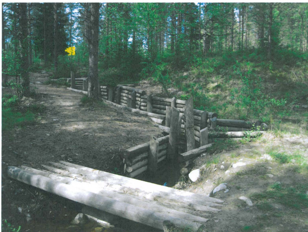
Kuva 22. Purasjoen aseman entisöityjä rakenteita Raatteen tiellä. Kuvattu lännestä.
