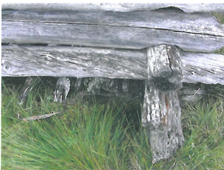
Keminperä niittylato, lounaiskulman lattiarakenne.
