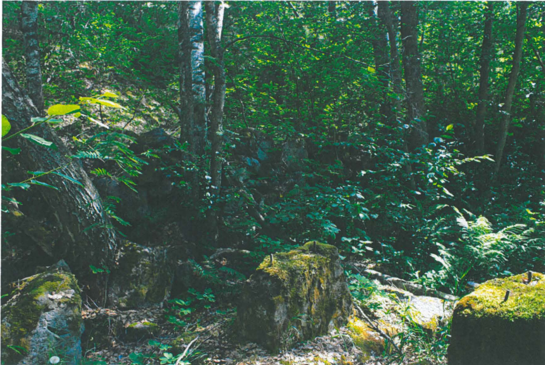
Kylmämuurattu rakenne runsaan kasvillisuuden keskellä. Etualalla betonista valettuja tukirakenteita. Kuva luoteesta. Lintulanoja2011_1.jpg
