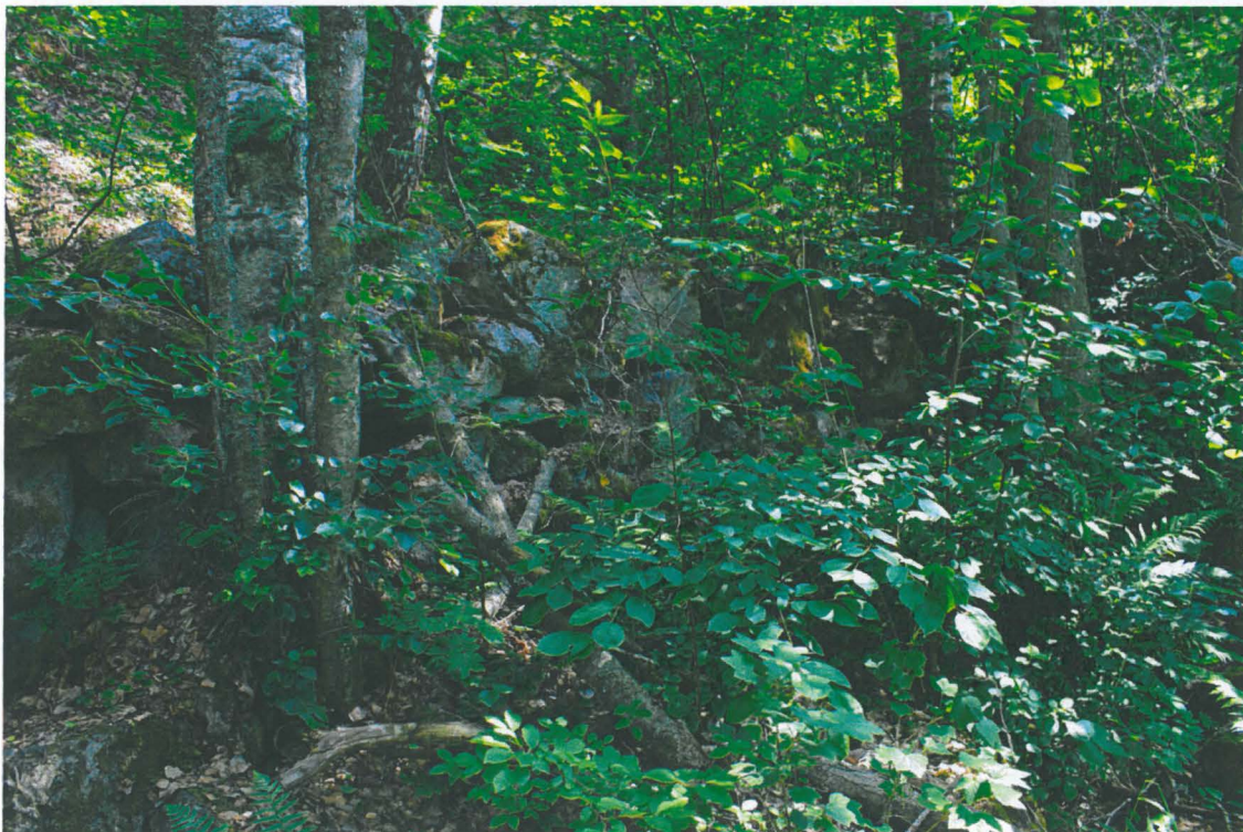
Kylmämuurattu rakenne. Kuva luoteesta. Lintulanoja2011_2.jpg
