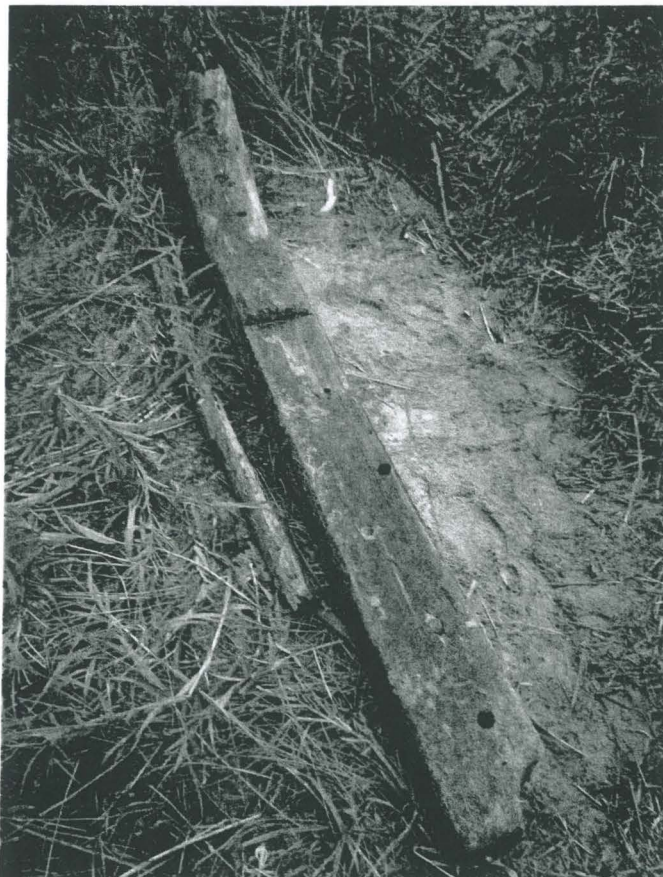
Kuva 8. Yksittäinen runkokaari päältä 16.7.2010 (PPM DG VH 5:2010:42:37).
