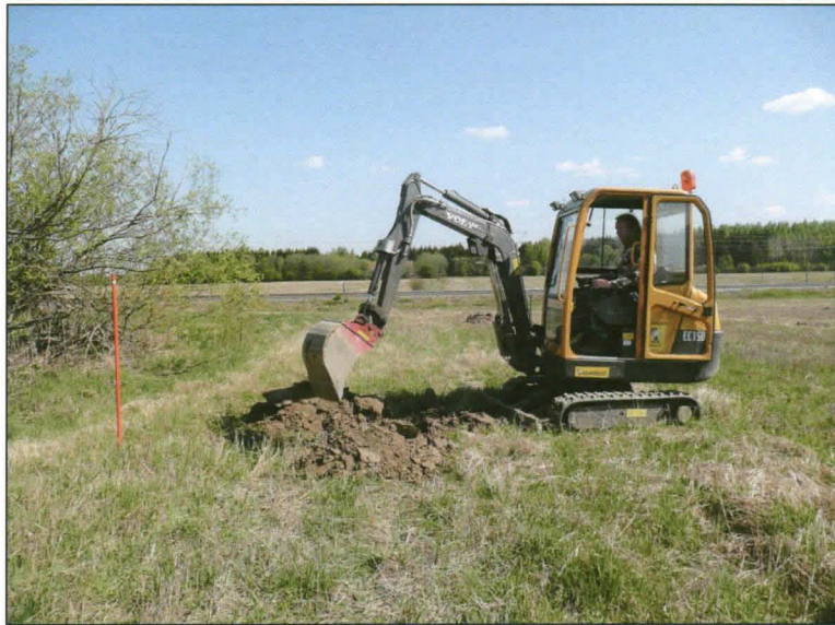
Koekuoppa kaivetaan, kaivuria käyttää T. Rostedt
