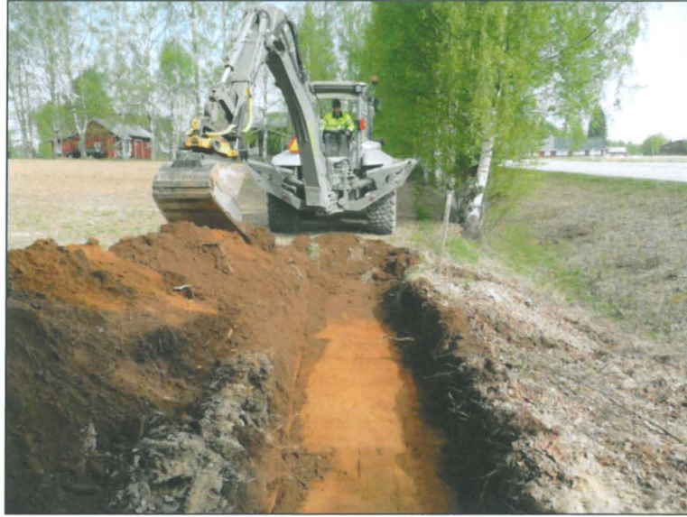
Kaivantoa kt.66:n länsipuolella
