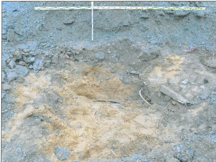
Kuva 1. Koeoja 1:n koillissivun leikkaus, osa 1/7 (luoteisin osa). Lounaasta. Esille tulleita kaapeleita näkyvissä.
