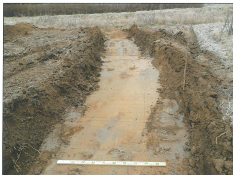
Kaivannon pohjoisosaa kuvattuna kaakosta
