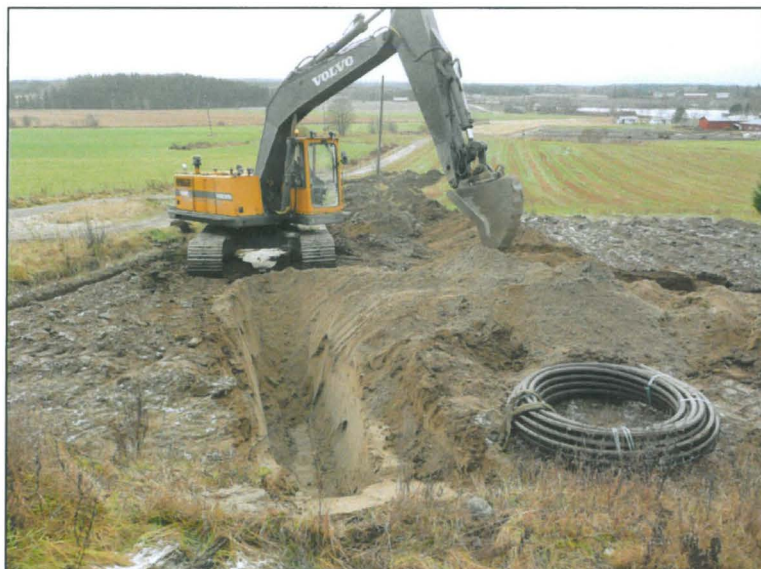
Kaivantoa kaivetaan kapealla kauhalla määräsyyvyyteen
