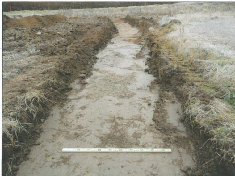
Kaivannon ylempää keskiosaa kuvattuna kaakosta
