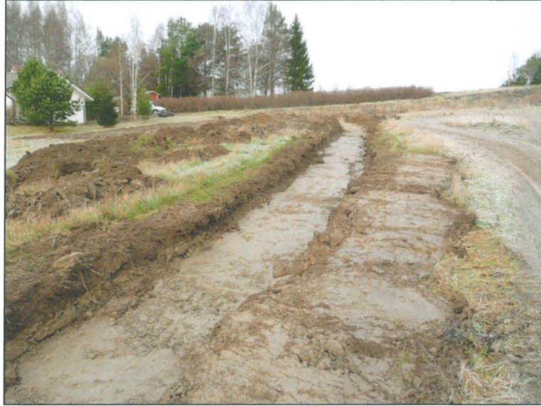
Kaivannon pohjoinen puolisko toiseen tasoon kaivettuna
