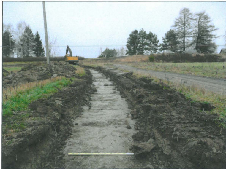
Kaivannon eteläinen puolisko toiseen tasoon kaivettuna
