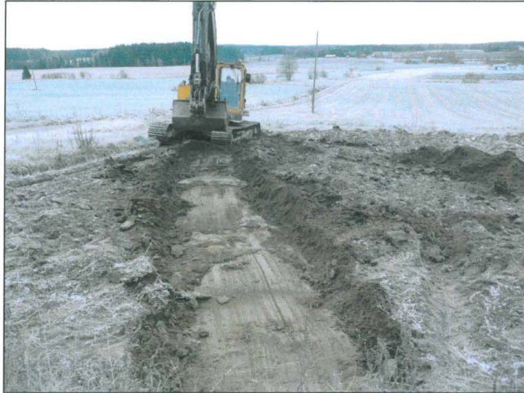
Maata poistettiin ensin muokkauskerroksen ja häiriintymättömän maa-aineksen rajalle
