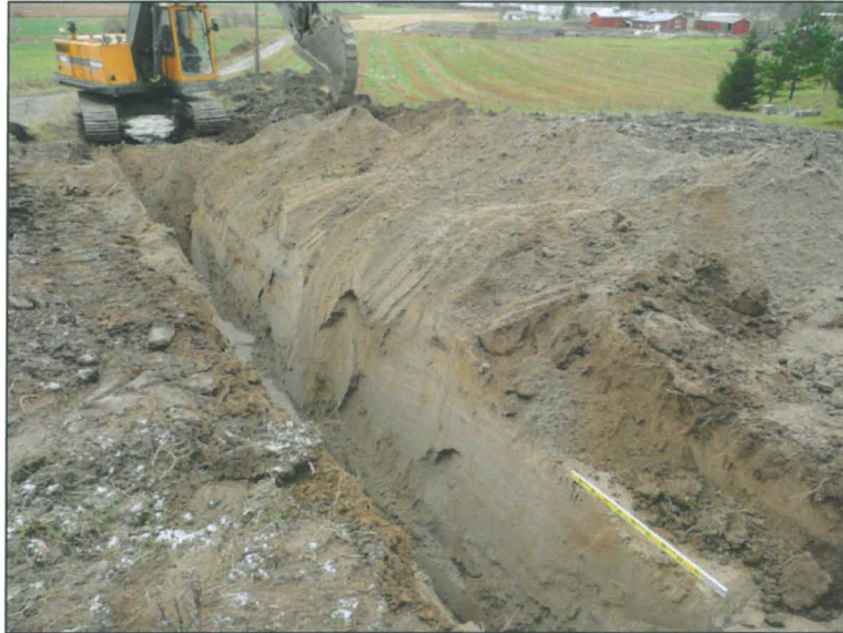
Määräsyvyyteen kaivettaessa tarkkailtiin ja tarkastettiin myös leikkauksia
