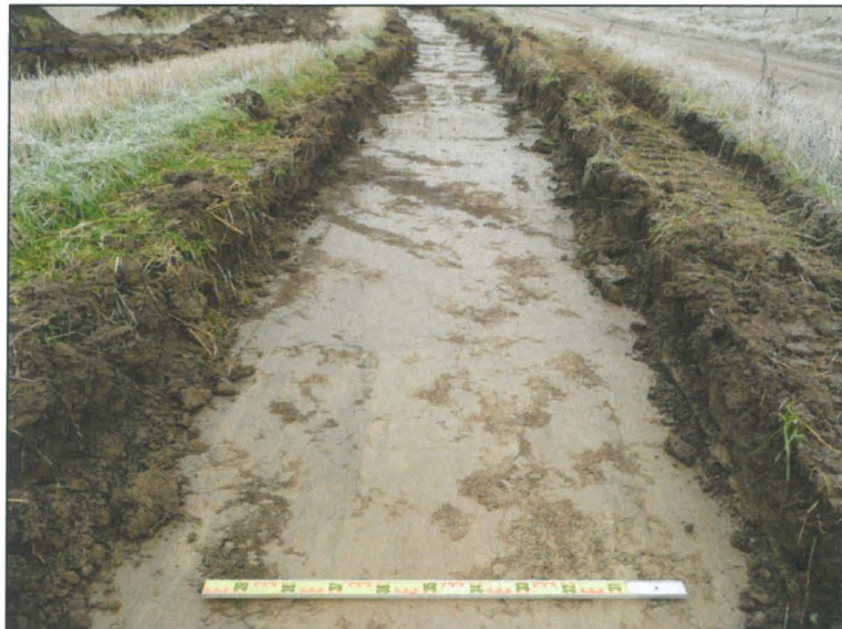
Kaivannon eteläosaa kuvattuna etelästä
