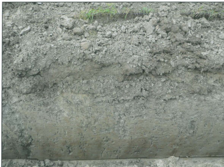
Kaivannon keskiosan seinämää
