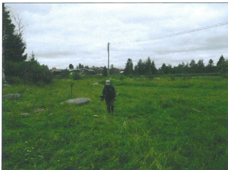
Metallinpaljastintutkimusta maakaapelilinjalla. Kuvassa H Poutiainen
