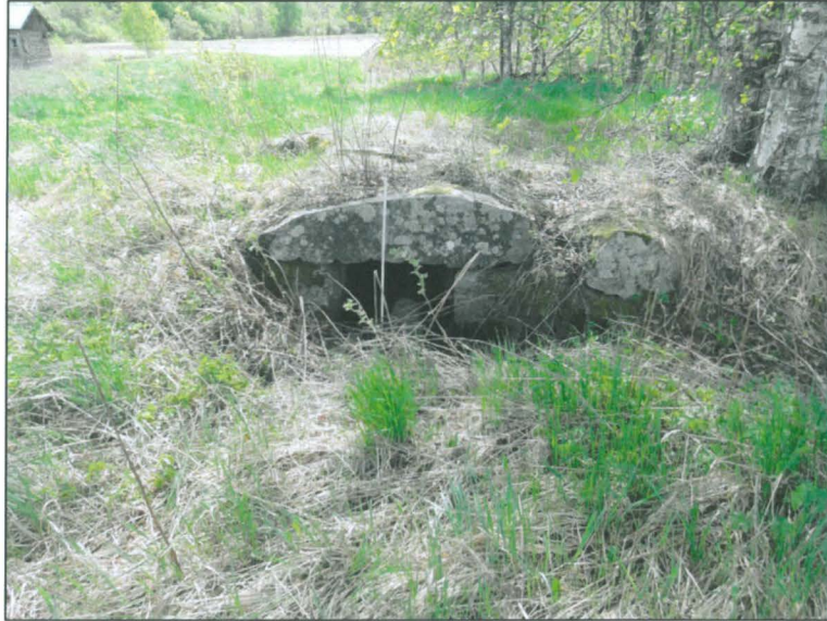
Vanha kivetty siltarumpu, hylätyllä tienosalla, virran länsipuolella.
