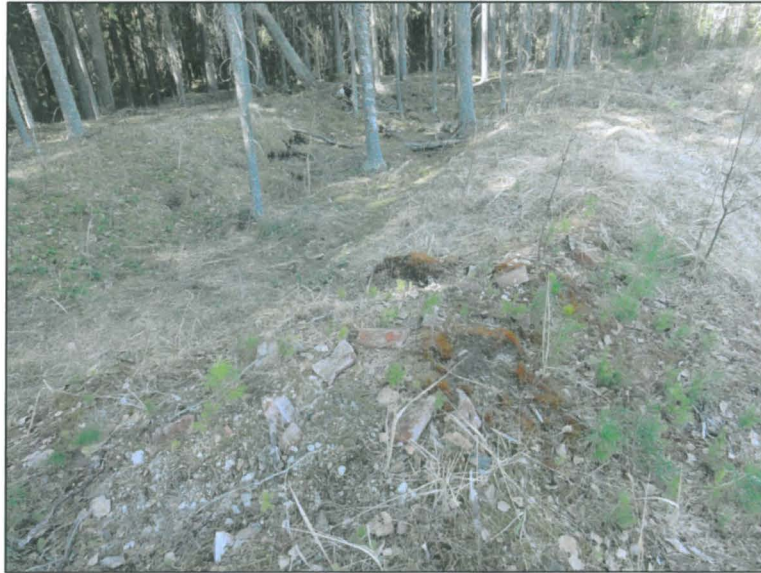
Kuivaamon tai höyrylaitoksen perusta radan varressa (pohjoiseen)
