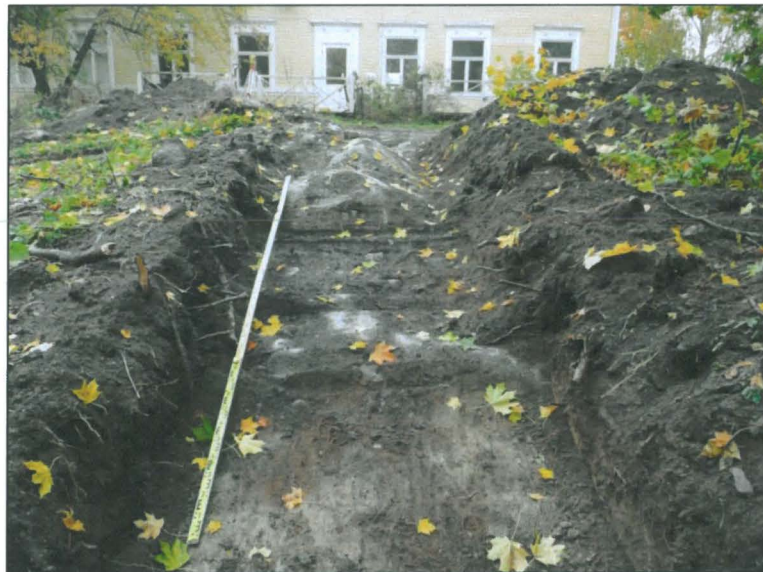
Eteläistä kaistaa kumpareen juurelta, kallio esiin kaivettuna
