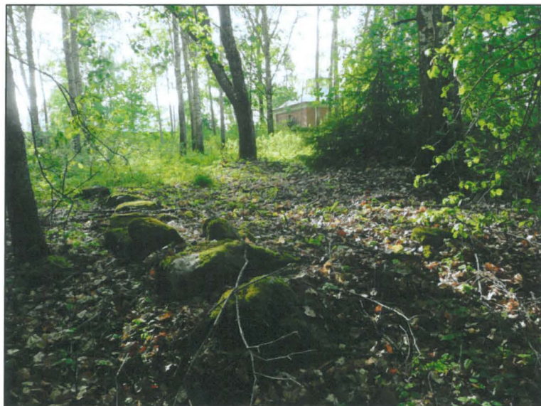
Rakennuksen perusta tontin itäreunalla
