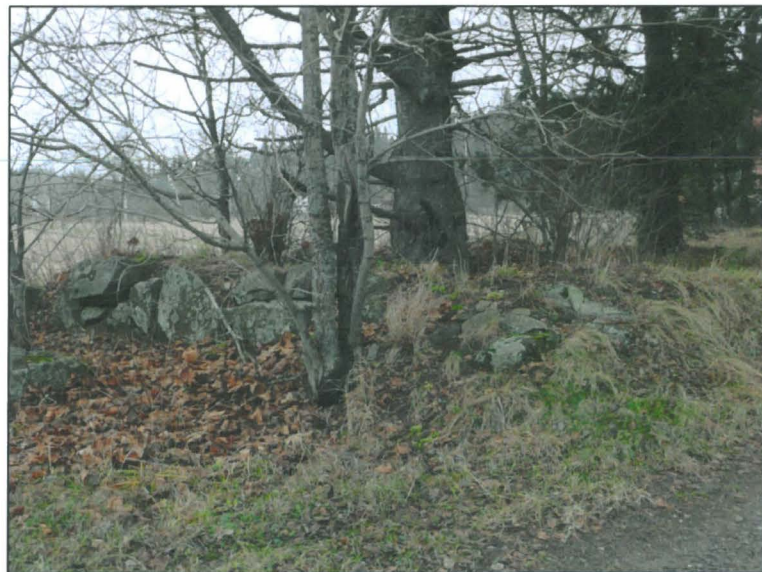
Rakennuksen kiviperustus maatalon pihapiirissä rajatun kylätontin ulkopuolella
