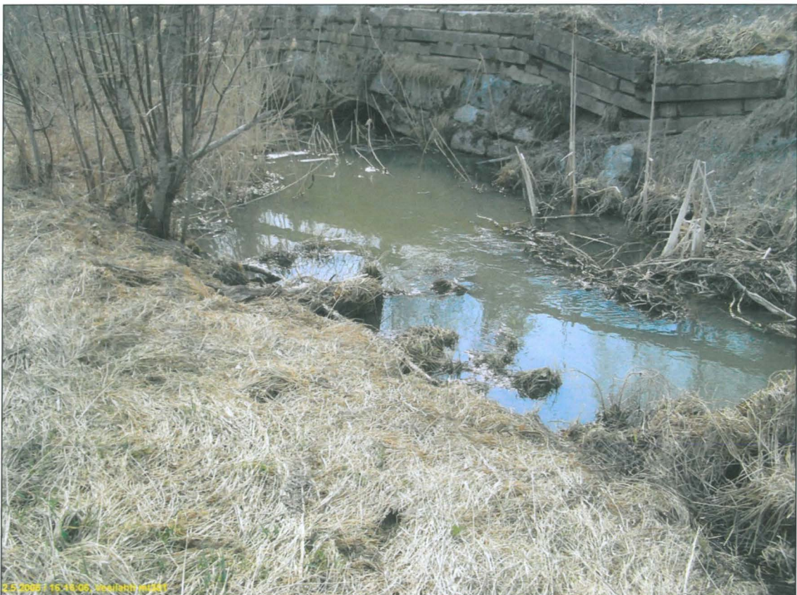
Mt. 301 Lihmonojan siltarumpu v. 2006
