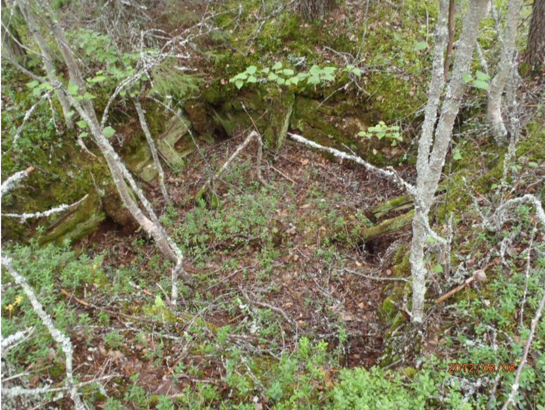
Sammakkokankaat, rakenteen sisäosa, kuvattu etelästä. Kuvaaja Inga Nieminen.
