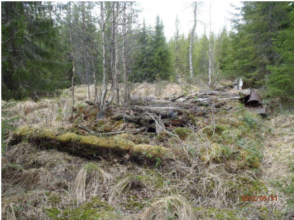
Kelukkajoki saunarakennus, kuvattu koillisesta. Kuvaaja Inga Nieminen.
