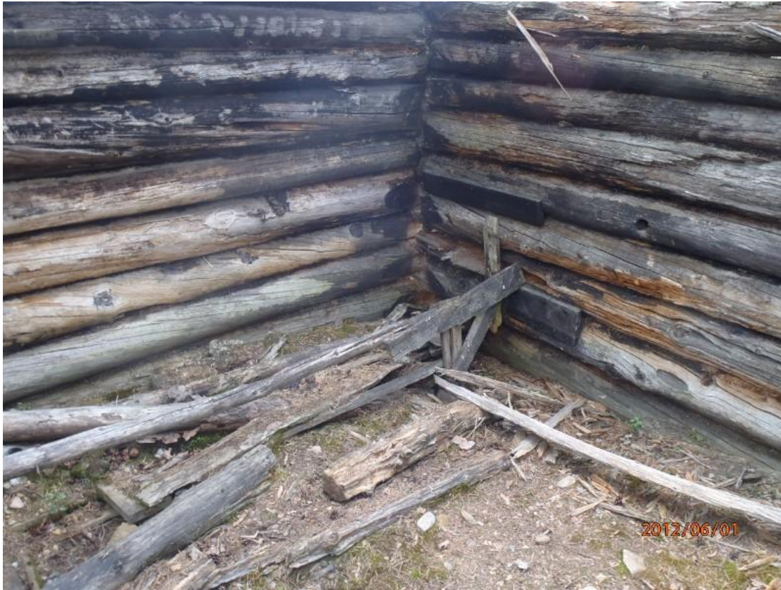
Tanelinlammen kalasaunan seinät ovat sisäpuolelta hiiltyneet ja itäseinällä olleiden lauteiden kiinnityspaikat ovat näkyvillä. Kuvattu luoteesta. Kuvaaja Inga Nieminen.
