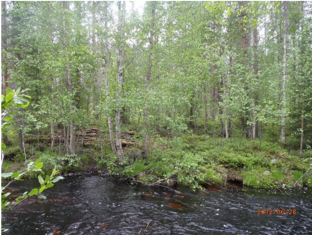
Mätäsjoen tammen purettuja puurakenteita etelärannalla, kuvattu pohjoisesta. Kuvaaja Inga Nieminen.
