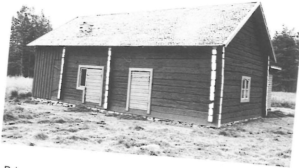
Rakennus korjauksen jälkeen .
