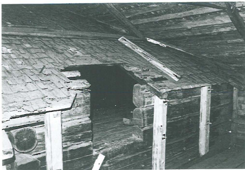
Kulkuaukko korjauksen jälkeen . Kuvassa tuki , jolla oikaistiin kujistin eteenpäinkallistuminen .
