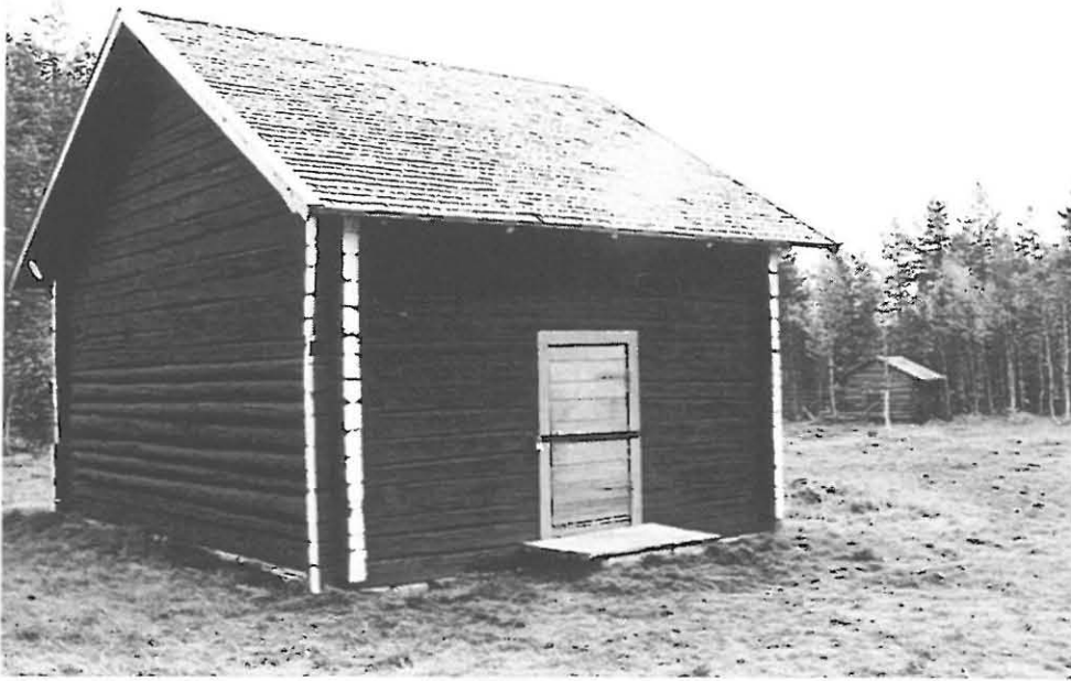
Makasiini korjauksen jälkeen .
