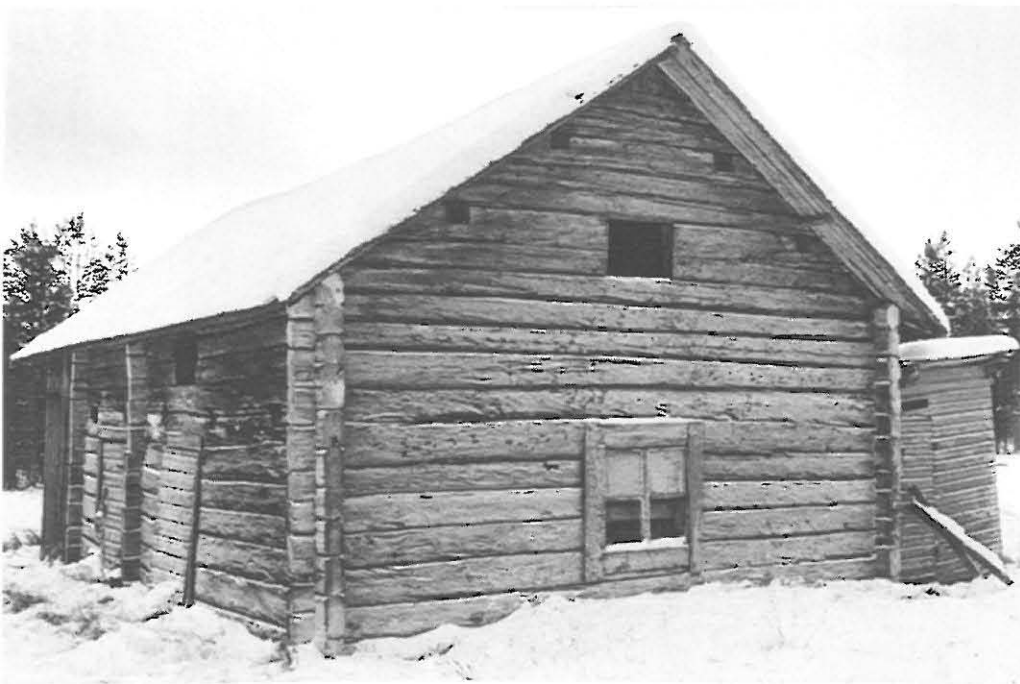
Rakennus ennen korjausta .
