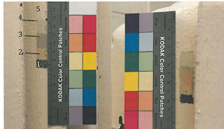
Vasemmalla ripapatterin kerrokset huone 113 ja oikealla huonetilasta 114 [1].
