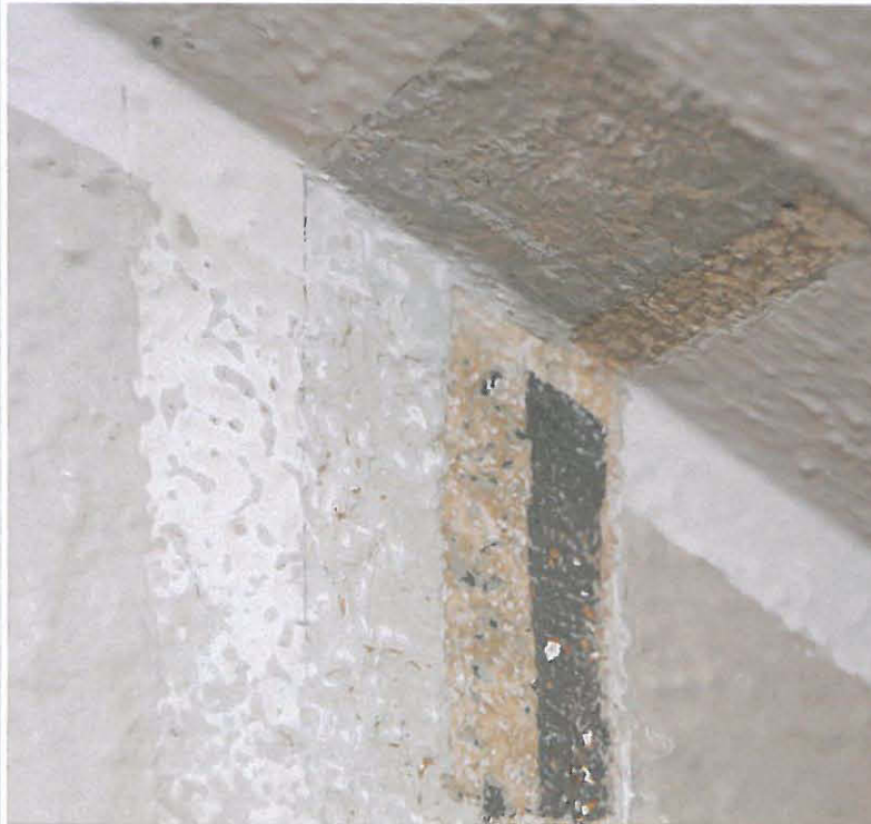
Seinän ja kattopinnan rajakohta [1. Portaikosta on nähtävissä katto- ja seinäpinnan maalausjaottelut.
