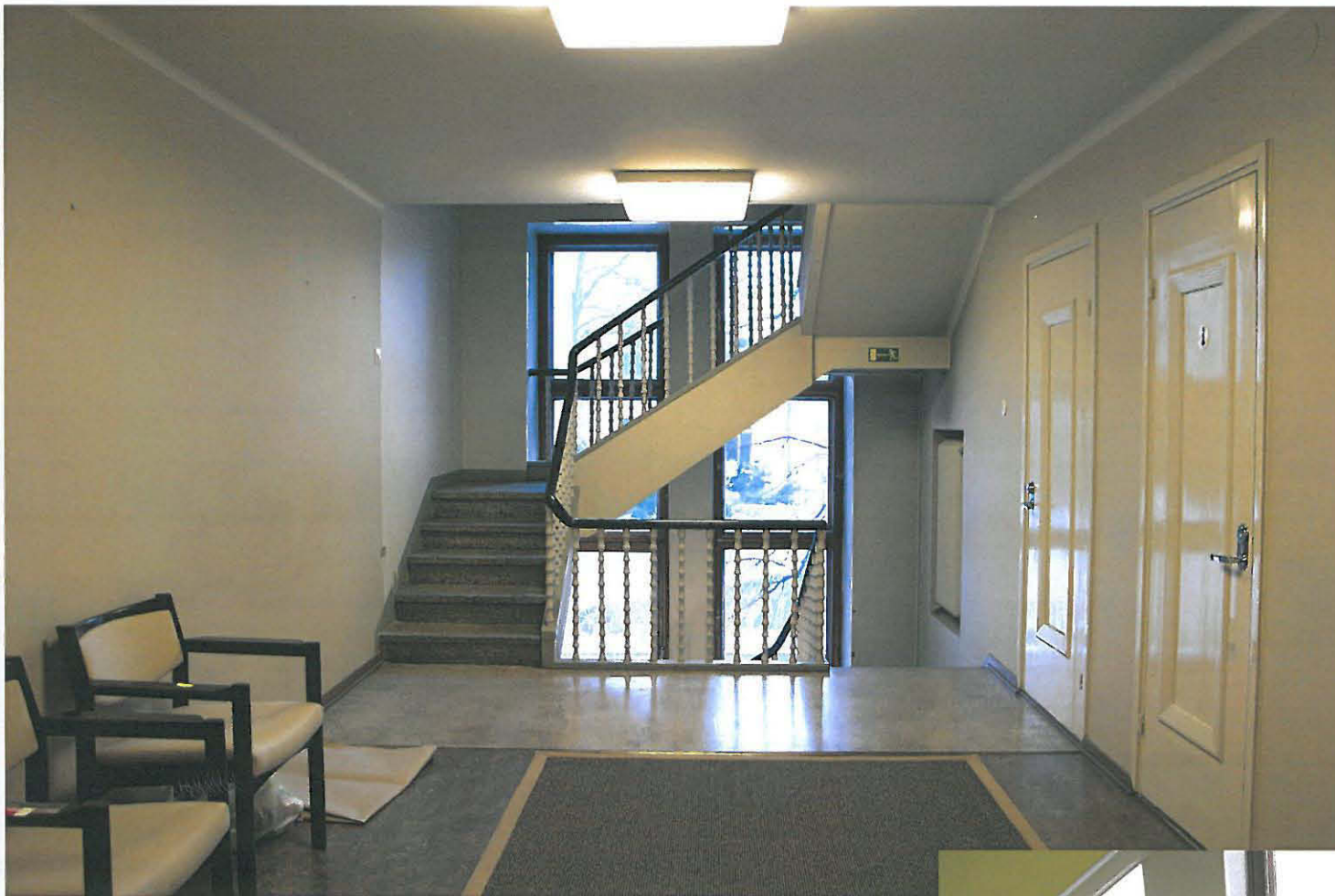
Sivuportaan aula II kerroksessa nykytilassaan [1.
