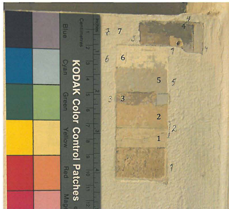
1950-luvun lasioviseinän päällipalkki ja sen värikerrokset [2.
