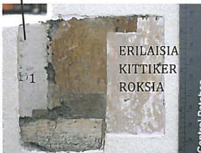
Ikkunaseinän maalikerroksia h 208 [3.
