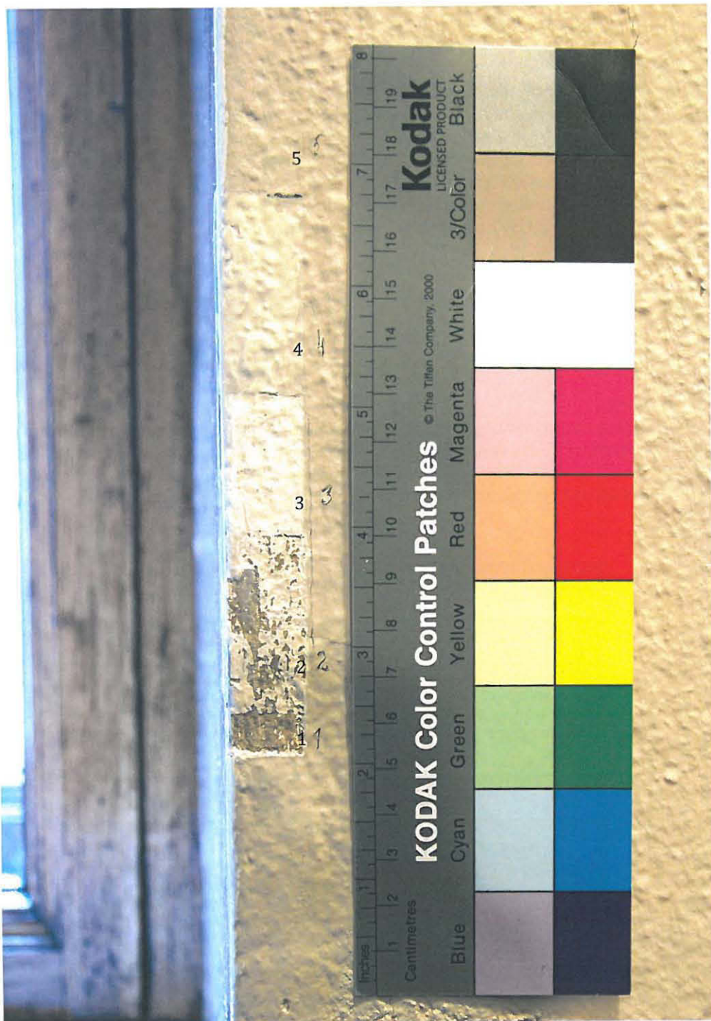
Huone 204. Ikkunoiden välisen seinäpinnan väriportaikko [1. Viereisen sivun smyygipinta on kulman toisella puolen.
