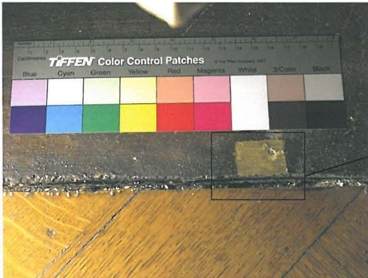
Keittiötasanteen patterisyyennöksen lattian värikerrokset yleiskuvassa [2.
