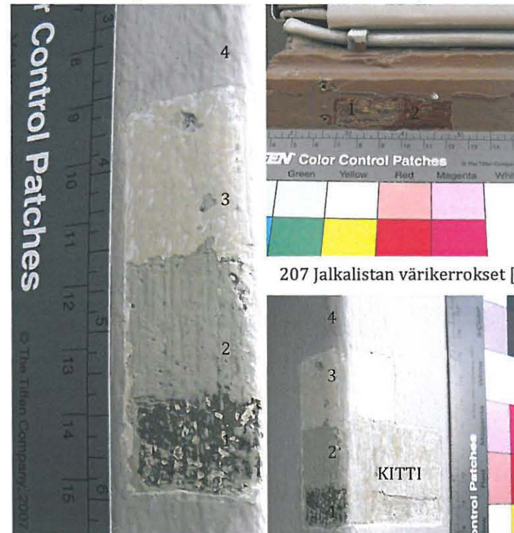
61 Yllä ja vieressä oikealla patterisyyvennoksen smyygin pintaa huoneesta 207 [3.
