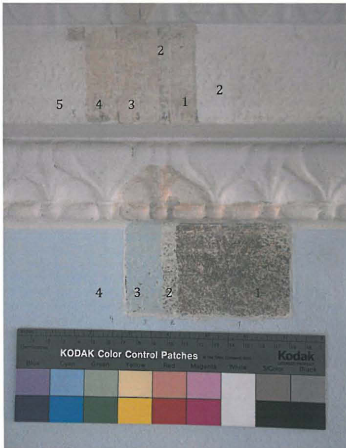
Tornihuoneen kattolistan ja seinäpinnan väriportaikko [2].
