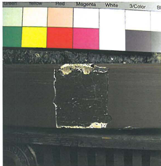
Ritilän ja ikkunapenkin alimmat kerrokset: Alin maalipinta on tumma ruskea [3.
