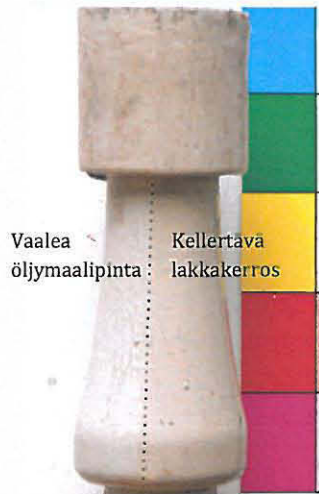
Käsijohteen värikerrokset (yllä [3]. Oikealla kaiteen pintaan tehty tutkimusavaus [3. Vasemmalla kellarista löytyneen pinnan värikerrokset [2.
