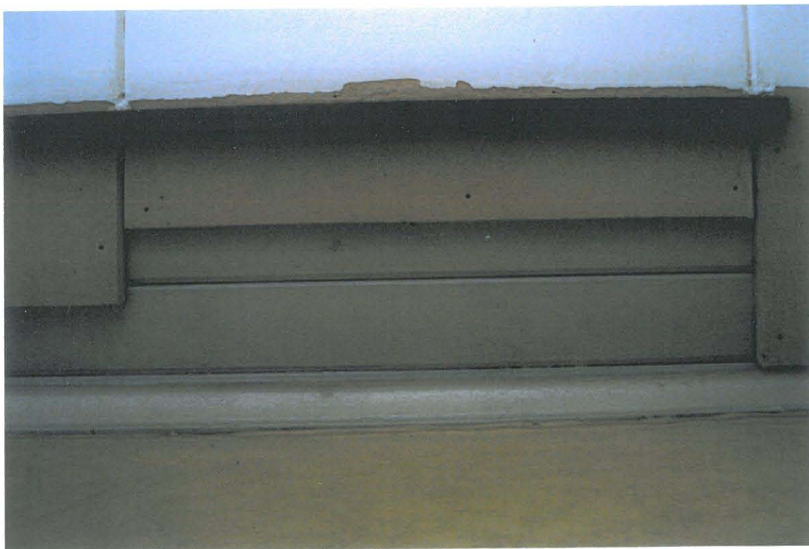
Katto / Seinä 2, loisteputkivalo
