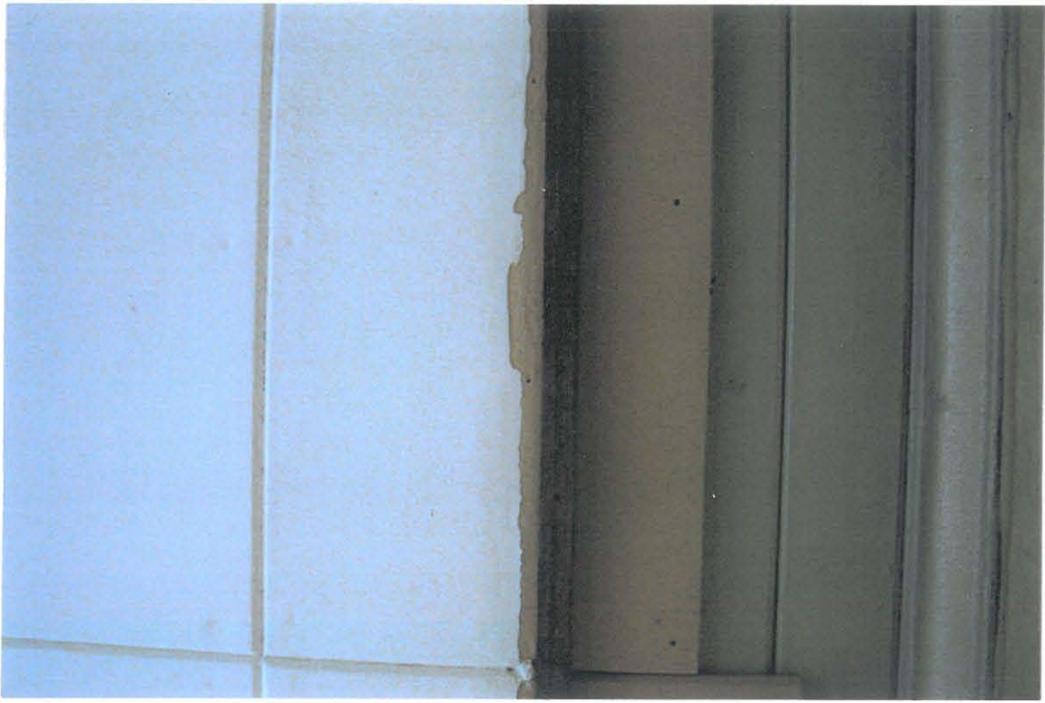
Katto / Seinä 2, loisteputkivalo
