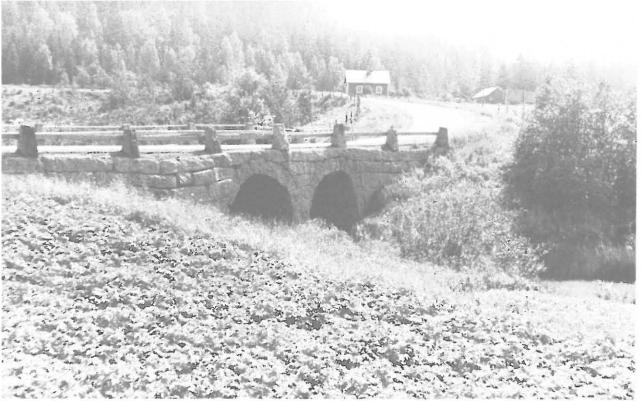
34. Iitti, Vuorenmäen silta.
