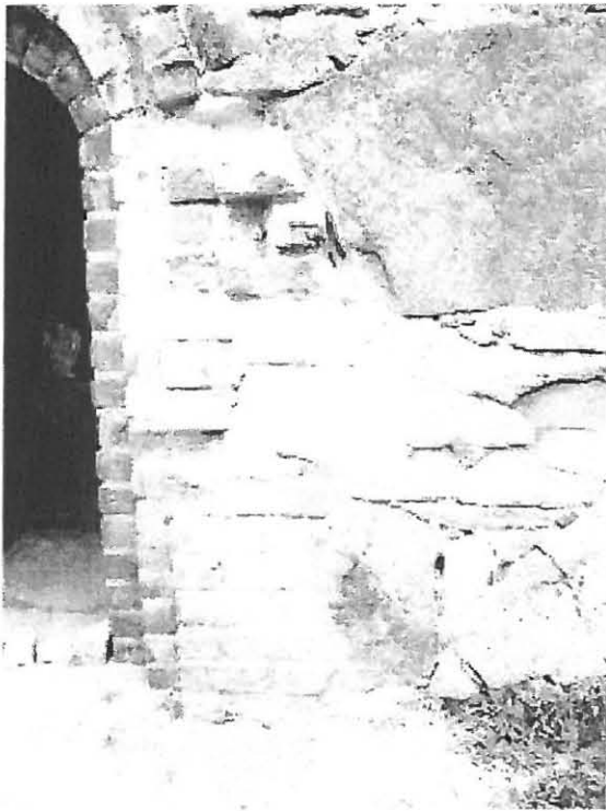
Kuva 1. Sakariston oviaukon tiilirakenteiden saumaukset.
