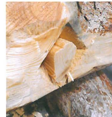
6. Tapin kanta sahataan tasaan ruoteen yläpinnan kanssa.
