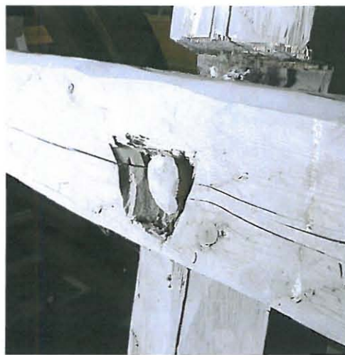
Lyhyen tapin kanta jää liitoskappaleen tasoon. Kuva on Hahtulan kirkosta. Esimerkki tappityypistä 1.
