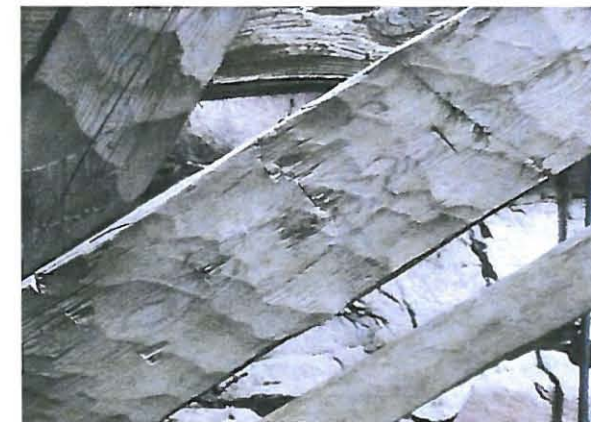
1600-luvun veistojälkeä Hollolan kirkon asehuoneen kattorakenteessa.
