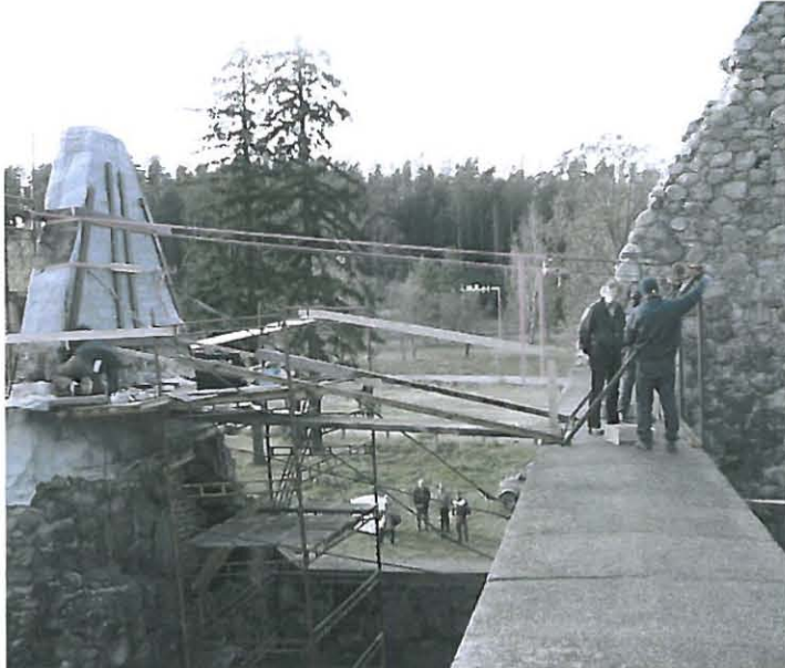
Asehuoneen päädyn suoristaminen taljojen ja ketjujen avulla on käynnissä syksyllä 2004. (Sanna Ihatsu, Museovirasto.)
