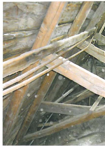
Itäpuolella, saksipuun päällä on jäljellä takonauloin selkäpuihin kiinnitetty reivi. Länsipuolella on vastaavissa kohdissa naulanreiät.
