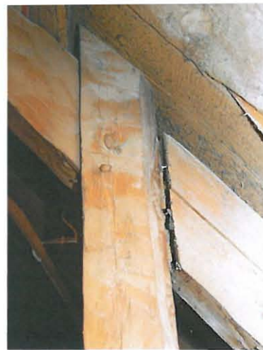
Kappaleitten päät ulottuvat lähes aina liitoksen ohi.
