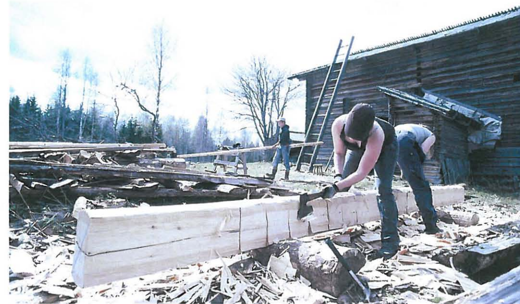
Tukin veistämistä Murtovaaran korjausteirillä vuonna 2008. Tukkiin on tehty moottorisahalla mittaurat.
