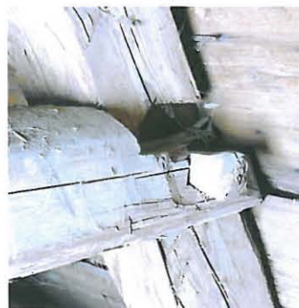
Kitapuun haljennut pää rakenteen ylä osassa kirkon länsipäässä.
