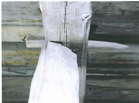
Rakenteessa on käytetty pitkiä teräviä tappeja.
