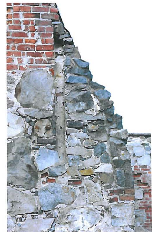
Konttipuut asennetaan muurissa olevien vanhojen konttipuiden painaumien kohdalle.
