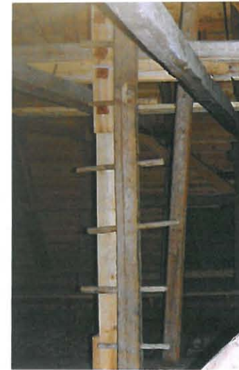
Puolatikkaat ja huoltosilta Hattulan kirkossa.
