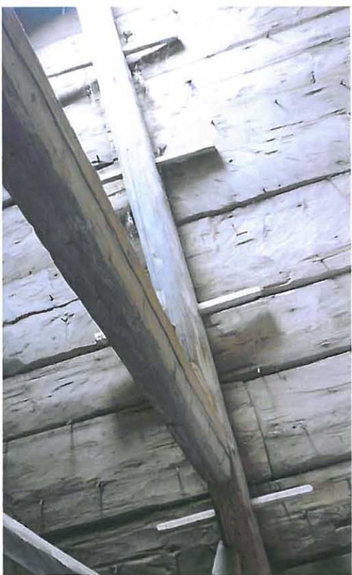
Akaan keskiaikaisessa sakastissa tappeja on hyödynnetty osana puolatikkaita. Esimerkki tappityypistä 2.
