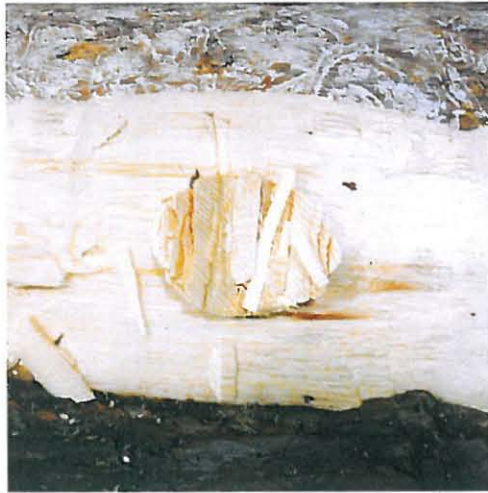
Kaksi esimerkkiä valmiista kärjen puolelta kiilatusta tapista.
