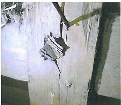
Tapin kanta on säilytetty ja siihen on lyöty kiila.
