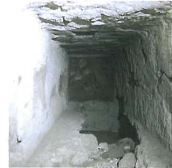
Konttipuun jättämä reikä muurauksessa. Kuvan alaosassa näkyy myös kápälän onkalo.
