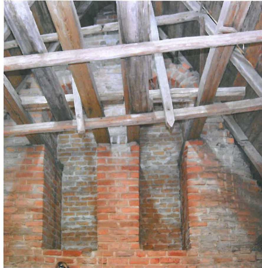
Umpeen muuratut ääniaukot ja kellojen vaatimia rakenteita asehuoneen vintillä.
