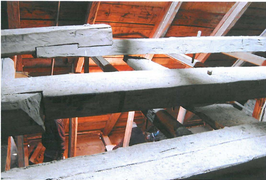
Päätykolmion runkohuoneeseen sitovia vetopuita.
