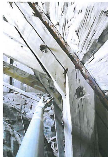
Konttipuun yläliitos ja saksipuun alaliitos osuvat monin paikoin samaan kohtaan selkäpuuta. Tällön lovia ei ole voitu tehdä kovin syviksi.
