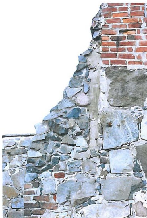
Päätykolmion purettaviksi suunnitellut alakulmat on muurattu 1950-luvulla. Uudelleenmuurauksessa on huomioitava keskiaikaisen muurin raekoko.
