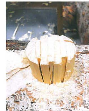
5. Kiilat lyödään paikoilleen.
