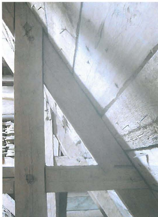
Kitapuun, konttipuun ja selkäpuun muodostamassa kolmiossa on useassa kohdassa jätetty tapittamatta yksi tai kaksi liitosta.
