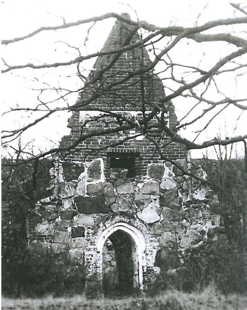
Asehuoneen päätykolmio ennen alakulmien täyttömuurausta. (Museovirasto. Historian kuva-arkisto.)
