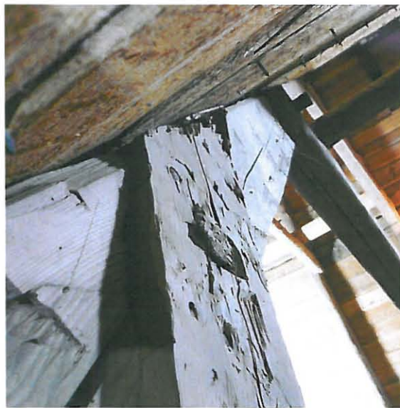
Konttipuun yläliitos, jossa on käytetty lyhyttä tappia.
