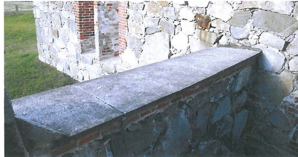
Asehuoneen länsiseinä. Tiilimuuraus ja laatat poistetaan.
