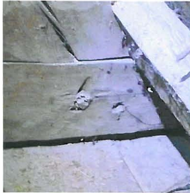
Rakenteesta löytyy läpiporausjälkiä.
