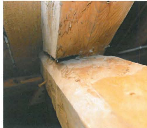
Liitos, jossa molemmat osat on lovettu puoleen väliin asti.
