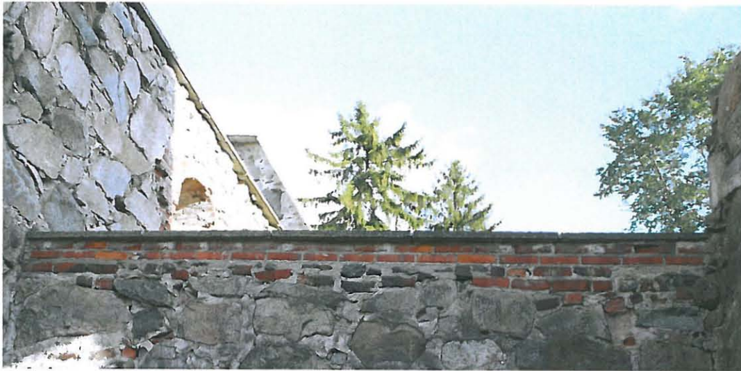
Asehuoneen itäseinä, ylimpänä purettavaa laatoituta ja tiilimuurausta.
