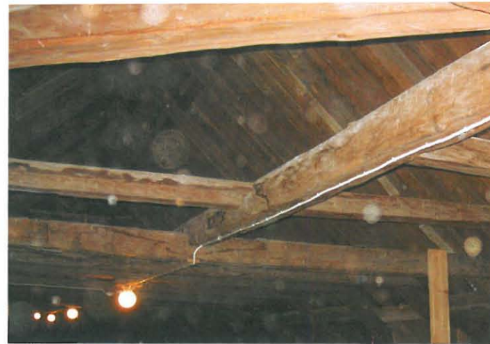
Nurkissa kattotuolit on yhdistetty kitapuiden jatkeilla.
