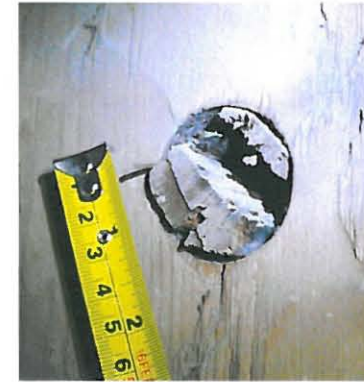
Rakenteessa on käytetty vaihtelevan paksuisia tappeja.
