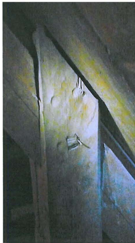
Rakenteesta löytyy läpiporausjälkiä.
