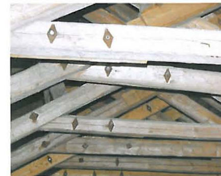
Rakenteeseen on tehty vahvistuksia.
