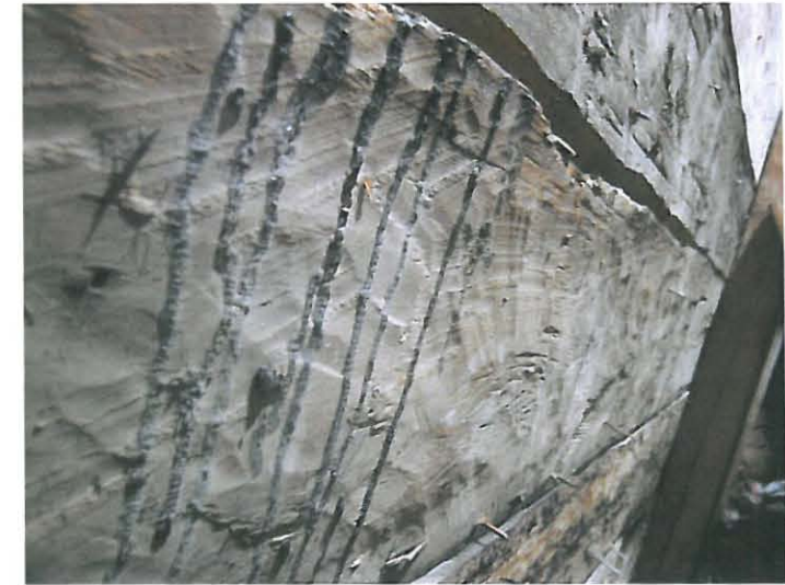
Kattotuolit on sidottu toisiinsa vaakasuuntaisella aluslaudoituksella. Lautojen leveys vaihtelee kahdestakymmenestä kolmeen kymmeneen senttimeetriin. Aluslaudoitus on rakenteen ainut harjansuuntainen tukirakenne.
