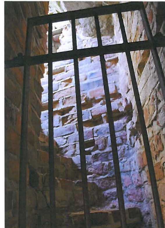
Muurin portaikon teräsportti Pälkäneen kirkon runkokuoneessa.
