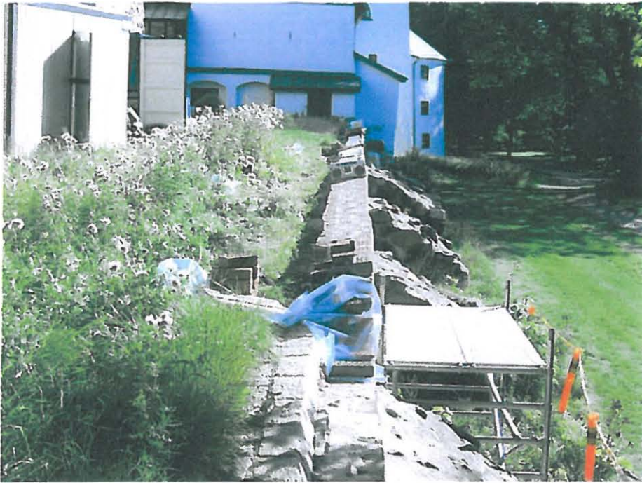
Korotuksesta tehtiin leveydeltään 1 ½ kiveä.
