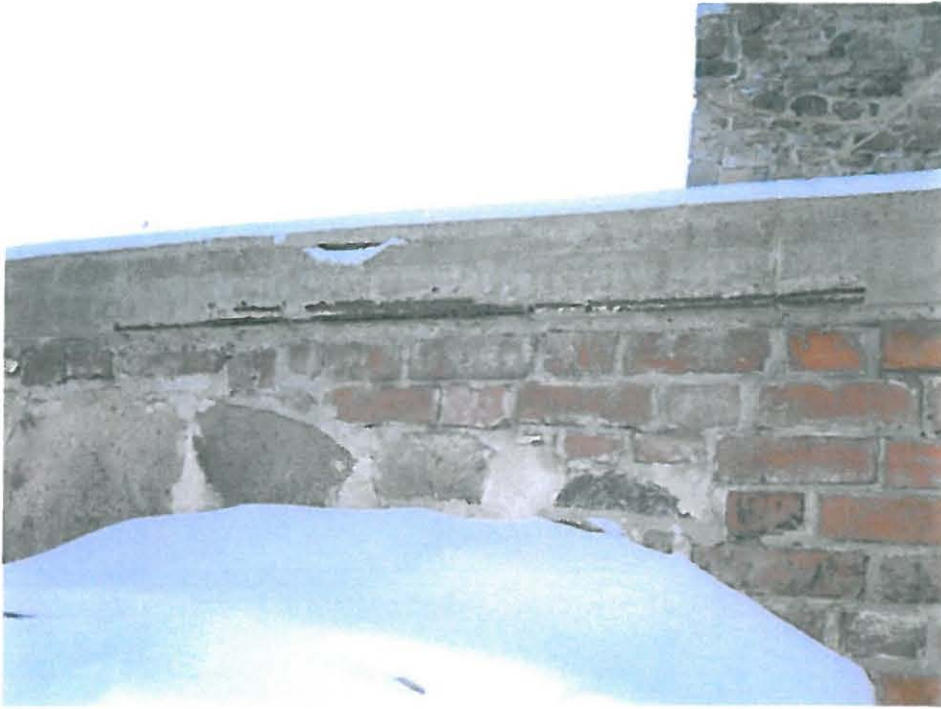
Pinnassa olleita harjateräksiä
