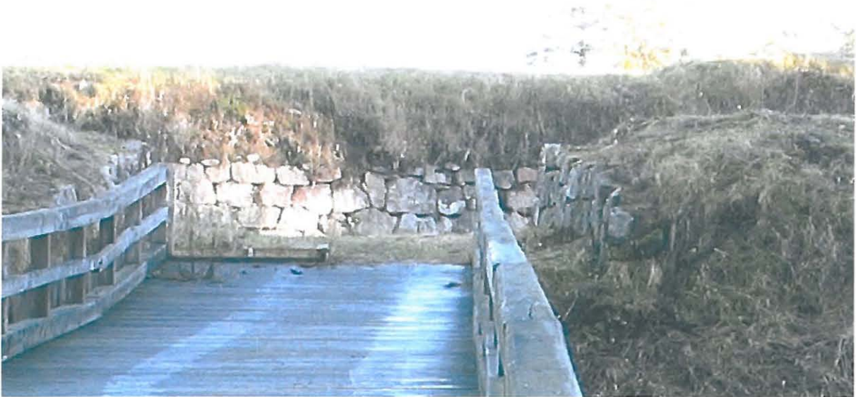
Ulkovarustusten muureja lounaisportin edustalla.
