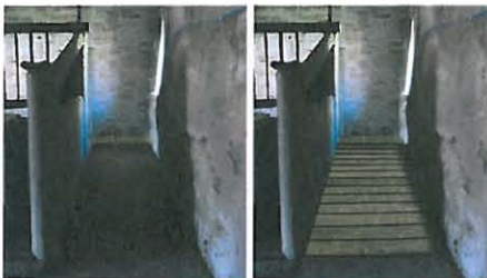
Kuva 28: Pilttuiden takainen käytävä saadaan käyttöön jatkamalla puisella (irto)lattialla käytävää täysilevyisenä seinään saakka ja rakentamalla siltä 2600mm pitkä 7,6% laskeva luiska alas.
