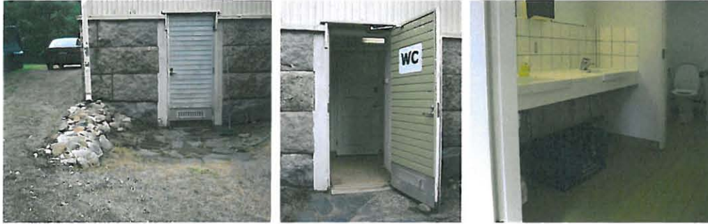
Kuva 36: WC-kyltti näkyy oven ollessa auki, mutta siitä puuttuu pyörätuolitunnus. Kynnys on suosituksia korkeampi ja ulko-oven jälkeen tuleva ensimmäinen sisäovi aukeaa apuvälineiden käyttäjien kannalta väärään suuntaan.
