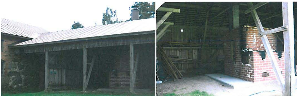
Kuva 30: Keramiikkauuni on käyttökiellossa ja sen tilalle rakennetaan grillikatos.
