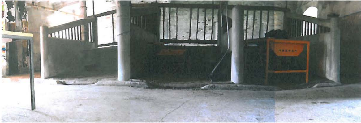
Kuva 23: Tallin neljä pilttuuta. Kynnykset ja niiden lattiat ovat kuluneet epätasaisiksi.
