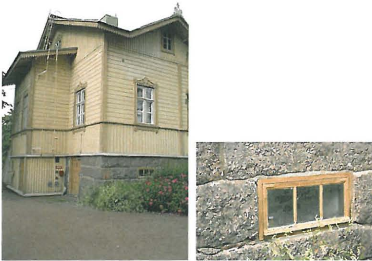
Kuva 12. Pytingin etelänurkka puiston puolelta ja kivijalassa oleva keskuslämmityshuoneen eteisen ikkuna. Kolmiruutuinen ikkuna on asennettu todennäköisesti 1940-luvun vaihteen peruskorjauksessa ja muurattu sisäpuolelta umpeen 1960-luvun lopussa. (Mäenpää 2010)
