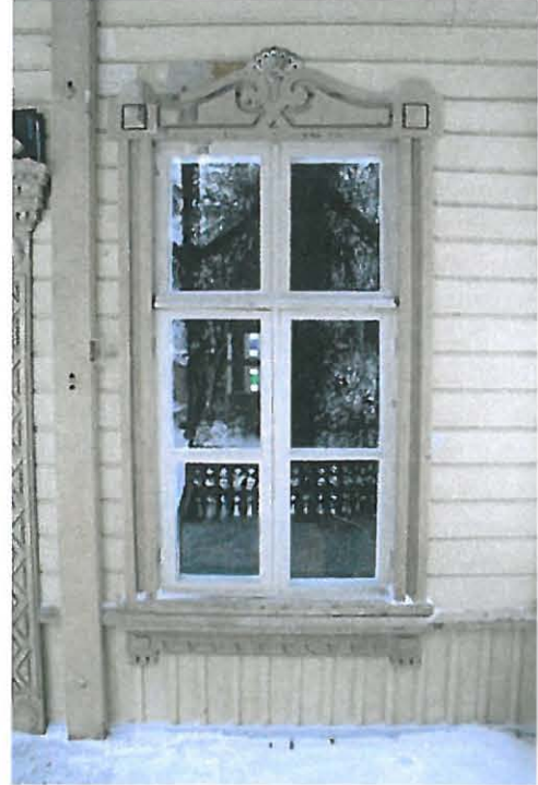
Kuvat 5 ja 6. Avoverannan oven ja ikkunoiden vuorilaudoitus. Koillispäädystä olevassa konttorin ovesa ja lounaispäädyn keittiön ovesa on samanlainen vuorilaudoitus kuin ikkunoissa.( Mäenpää 2011)
