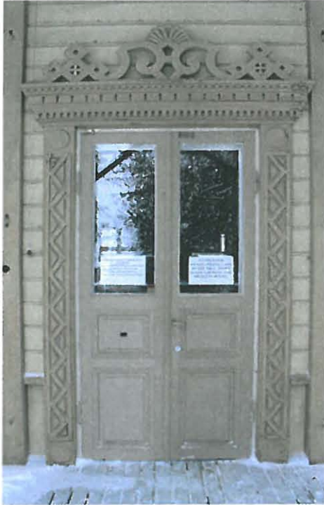
Kuvat 5 ja 6. Avoverannan oven ja ikkunoiden vuorilaudoitus. Koillispäädystä olevassa konttorin ovesa ja lounaispäädyn keittiön ovesa on samanlainen vuorilaudoitus kuin ikkunoissa.( Mäenpää 2011)
