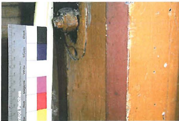
Kuvat 9 ja 10. Kesähuoneeksi muutetun avoparvekkeen etelänurkan pilari alaosa. Myöhemmin rakennettujen seinien sisään on jäänyt avoparvekkeen rakenteita, joissa on säilynyt laajennusosan toinen värikerros. (K9 Mäenpää 2011, K10 Mäenpää 2010.)
