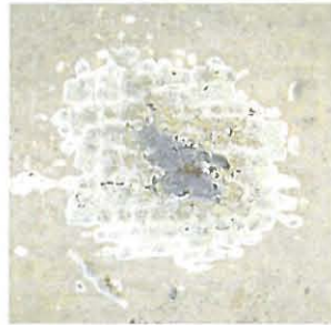
Kraaterikuva torniosan alemmasta vaakalautoitetusta seinäpaneelistä
