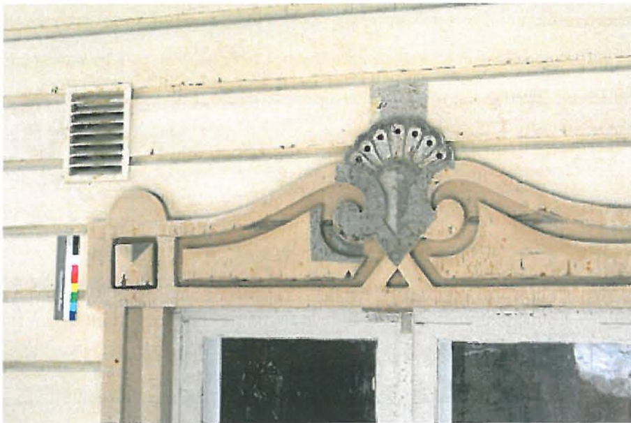
Kuva 6. Sinisen värikerroksen esiinotto avoverannan ikkunan vuorilaudoituksen yläosassa. Seinävärinä on siniharmaa, listaväri tummempi harmaansininen ja korosteväreinä on vihreä ja tummansininen. Esiinotto on tehty aikaisemmissa tutkimuksissa. (Mäenpää 2011)
