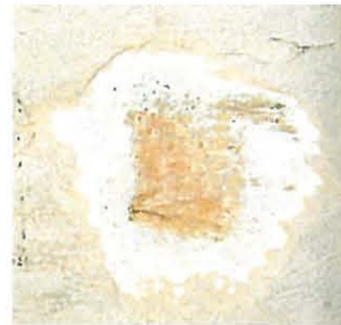
Kraaterikuva tornin kesähuoneen vaakalautoituksesta.
