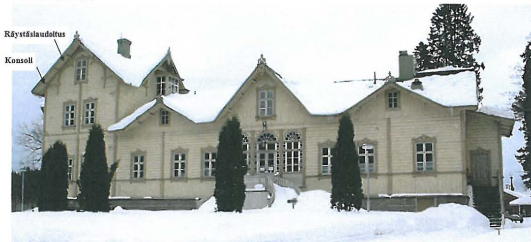
Kuva 2. Julkisivun yläosan rakenteiden nimityksiä luoteisjulkisivulla. (Verlan tehdasmuseo 2010)
