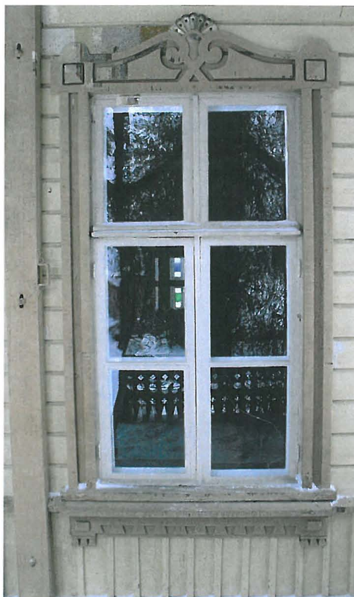
Kuistin ikkuna, johon on tehty suurin osa esiinotoista.
