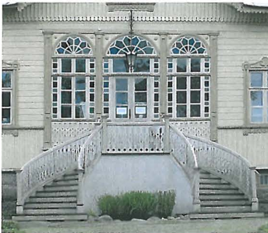
Kuva 3. Pääsisäänkäynti luoteisjulkisivulla. (Mäenpää 2010)
