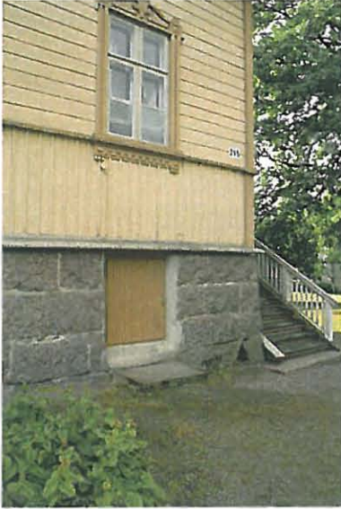
Kuva 13. Luoteisjulkisivun kivijalkaan on asennettu kellarin ikkunan kohdalle 1970-luvun vaihteen peruskorjauksessa kylmiöön vievä ovi. (Mäenpää 2010.)
