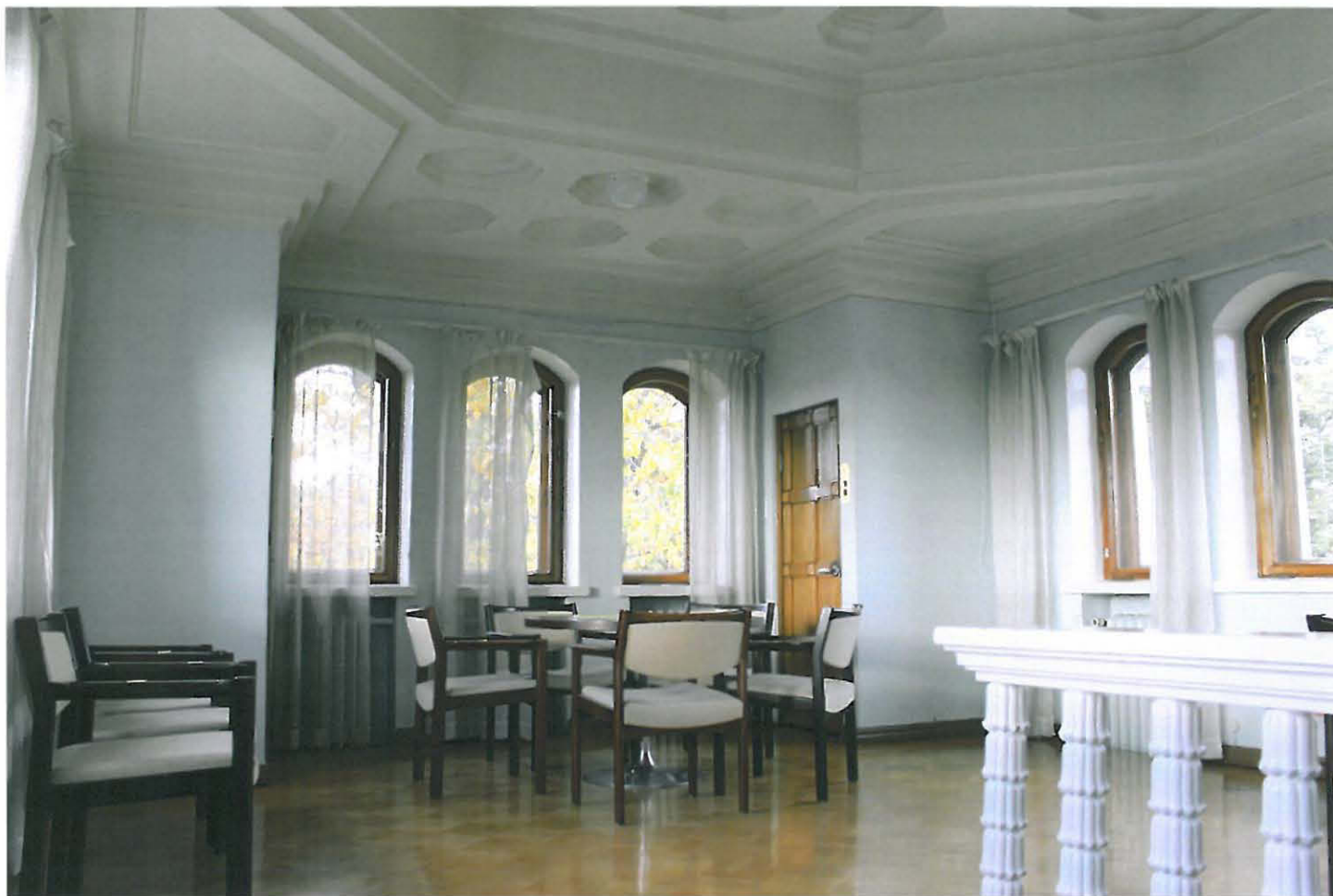
Massiivinen kasettikatto on betonirakenteinen ja se koostuu kahdeksankulmioista, joissa profiloituneet listat.
