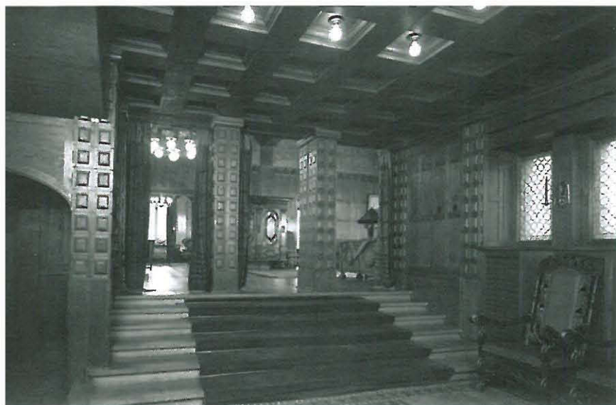
Eteishalli Waldenien aikana. Iffland / WA
