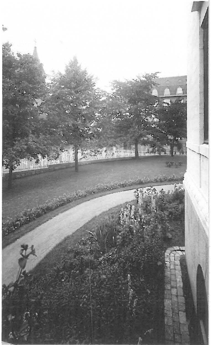
Marmoripalatsin pohjoista, Katolisen kirkon ja Tehtaankadun puoleista pihaa 1920-luvulla. Kuva otettu ensimmäisen kerroksen terassilta. Sundström / WA
