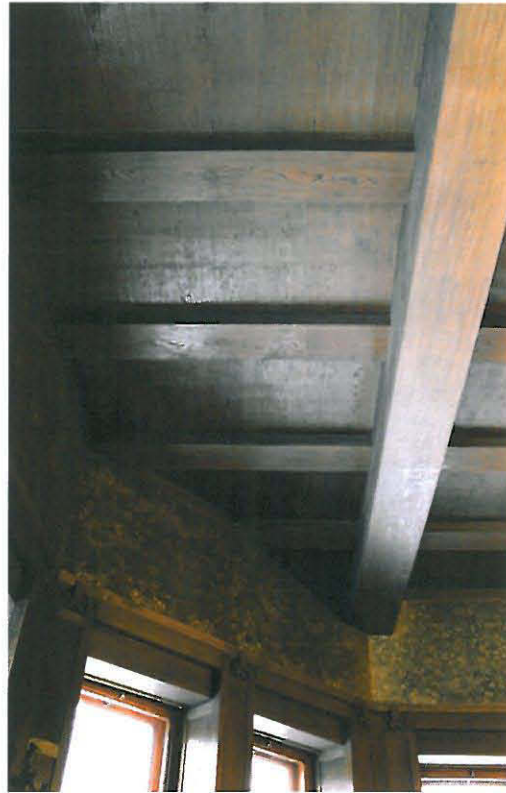
Kattopinta primääri- ja sekundääripalkkeineen on verhoiltu tammiviilulla. Seinäpinnan palkkien välit ovat myös tammaa. Tapetin yläreunassa puulista.
