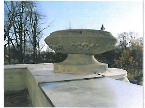
Maljamainen valettu ruukku teras- sin kulmassa on alkuperäinen.
