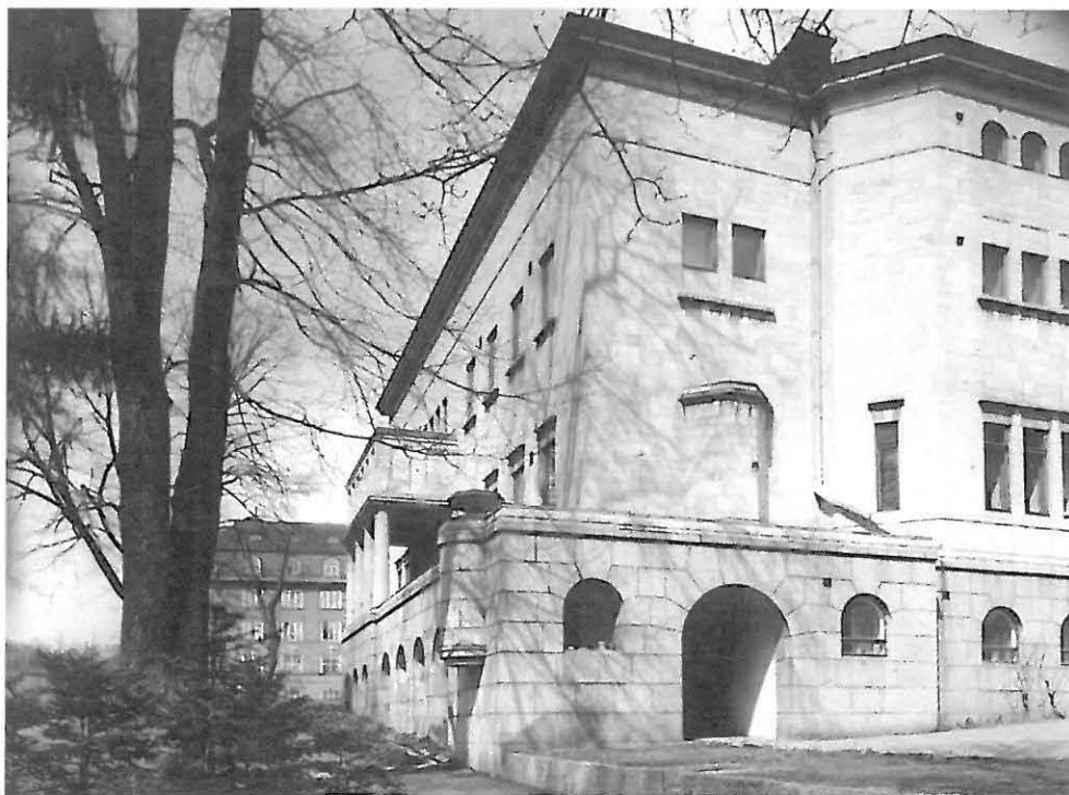
Todennäköisesti 1950-luvulla otetussa kuvassa lounaiskulman loggia on vielä alkuperäisessä asussaan. Marmoriseinässä näkyy useita sirpalevaurioita, joita on myöhemmin paikkailtu harmaalla laastilla. Havas / AM
