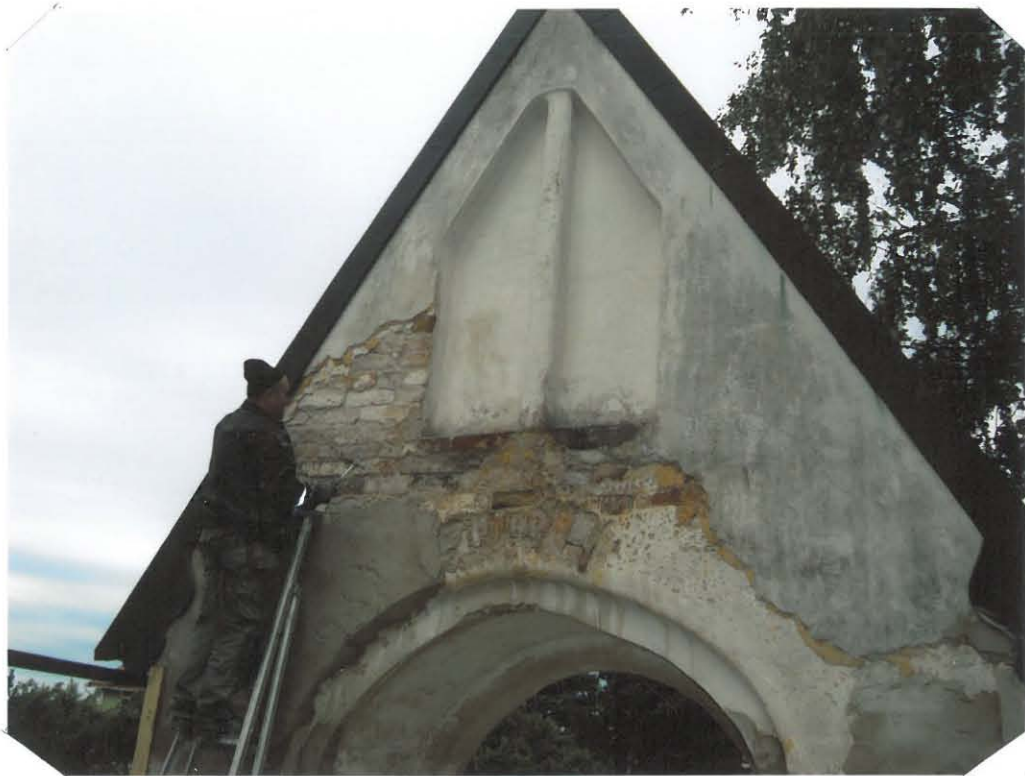
LÄNSIPORTTI / ITÄPUOLEN KAUKKILAKSTI- TÄYTTÖÄ
