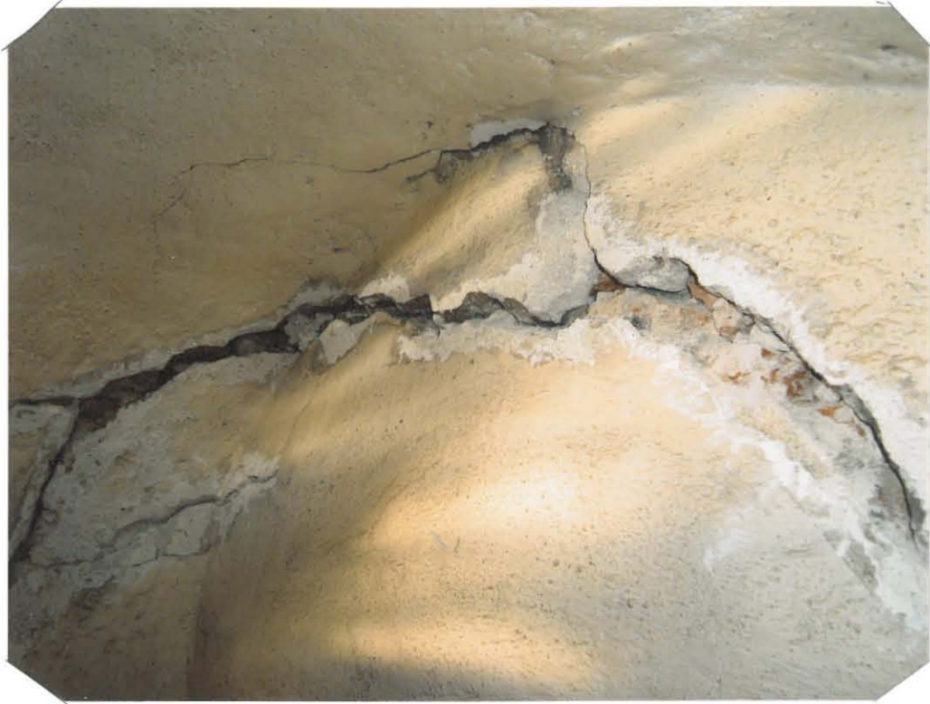
ETEL. IKKUNASMUUNGIN YLÄOSAA (3. KÄÄSTÄ) HALKEAMAN AVAVSTA
