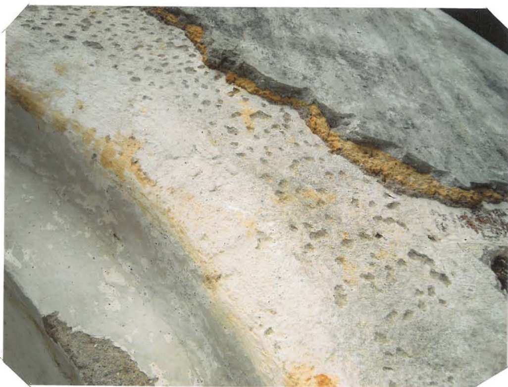
LÄNSIPORTTI / ITÄPUOLEN KAAREN YLÄOSAN ALUEPERÄISTÄ LAASTIPINTA YRT. YLÄKUVAN
