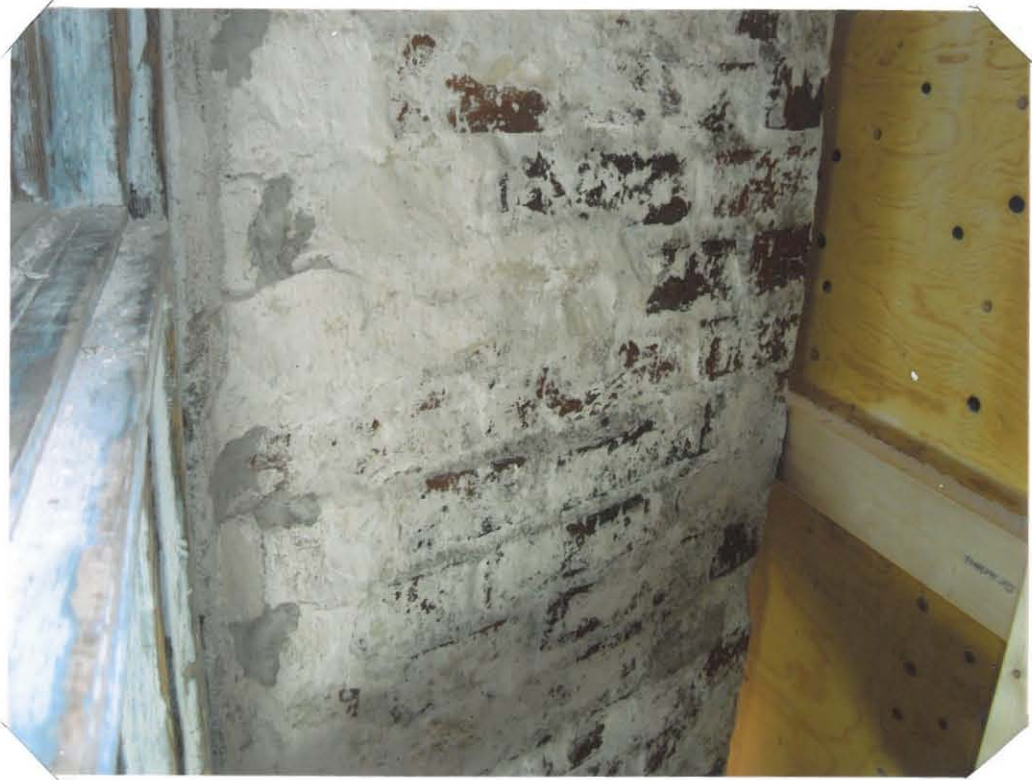
ETELÄISEN IKKUNASMYÖGIN KULMAA
