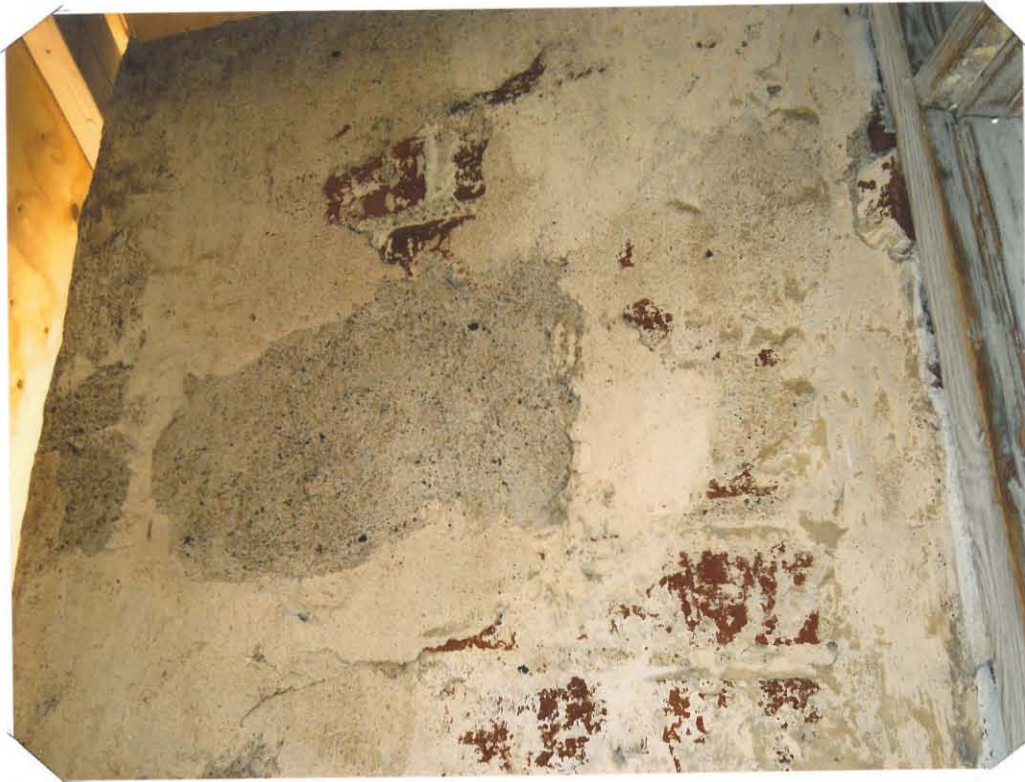
ETELÄ IKKUNA SIVYIN AIEMPA BETONIPARKKUSTA (KESKELÄ)
