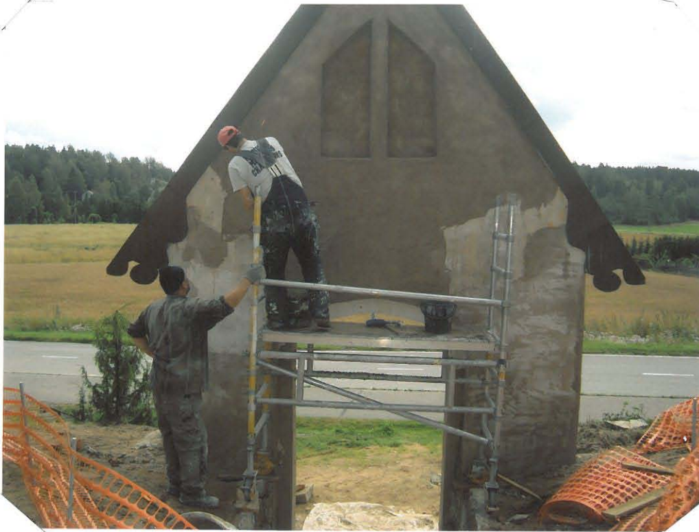
ETELÄ PORTTI / PUSTAN POSAT SLAMMAAMASSA
