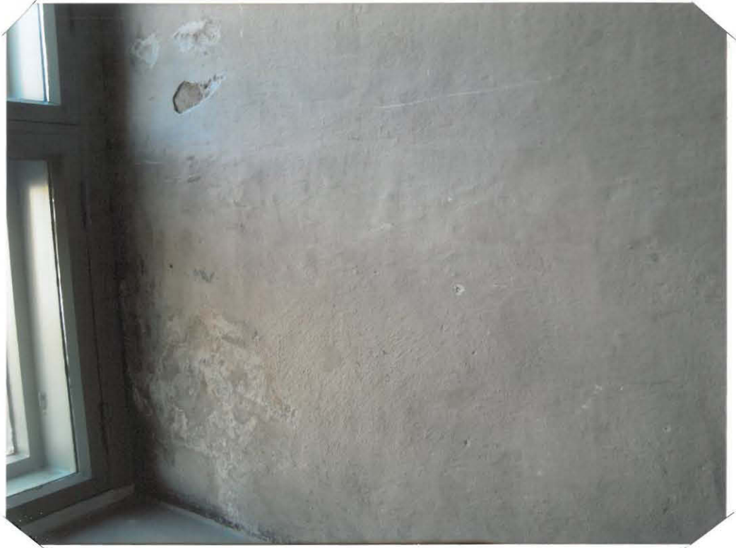
PÖLTY, IKKUNASMYYGIN KOSTEUSRAPAUMAA KAIKKI IKKUNARUUT KUNNOSTETTU V. 2010
