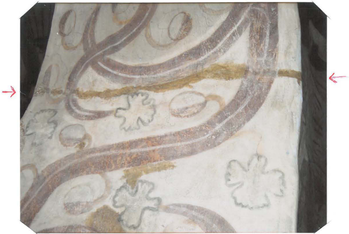
YÖSKAAREN YLÄOSAN HALKEAMAN PAIKKAUSTA JA HÄIVVYTYSTÄ
