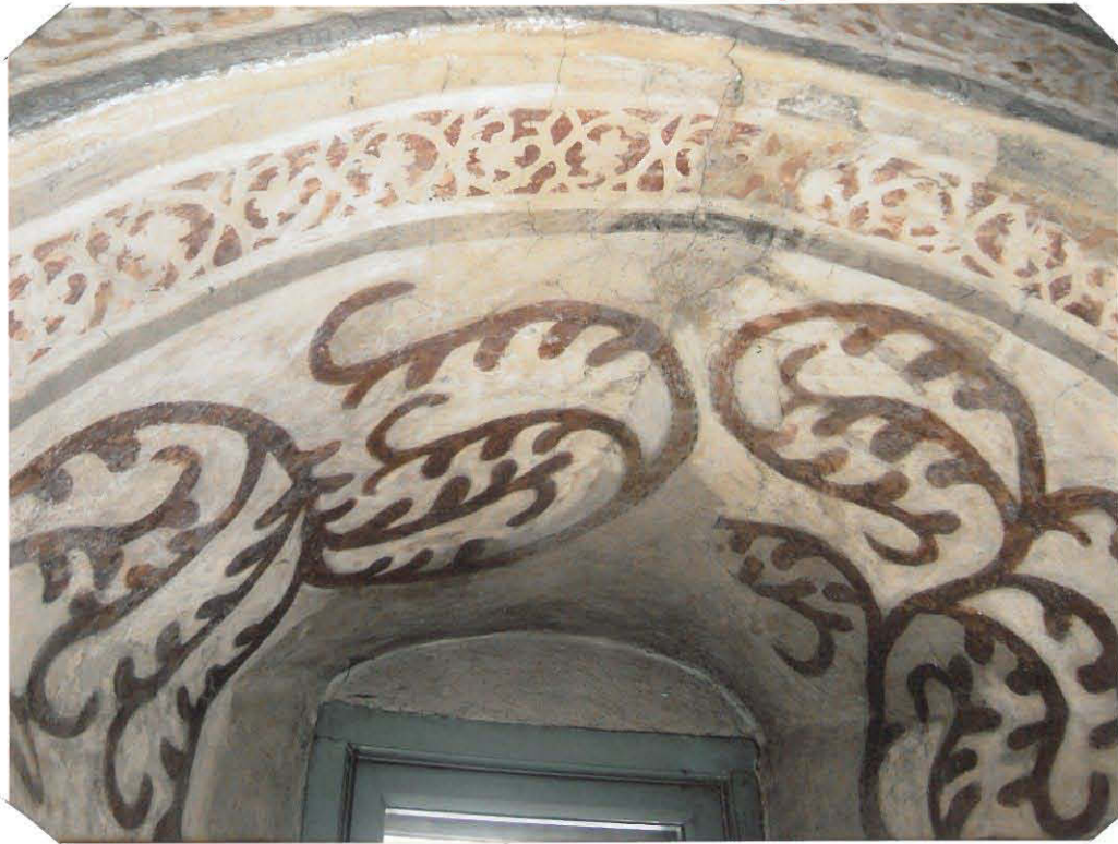
PIKKUIKKUNAN SMYUGIN YLÄOSAN PUHDISTUSTA HUOM. YLÄOSAN AIKAISEMPI PAIKKAUS ENNEN HÄIVYTYSTÄ
