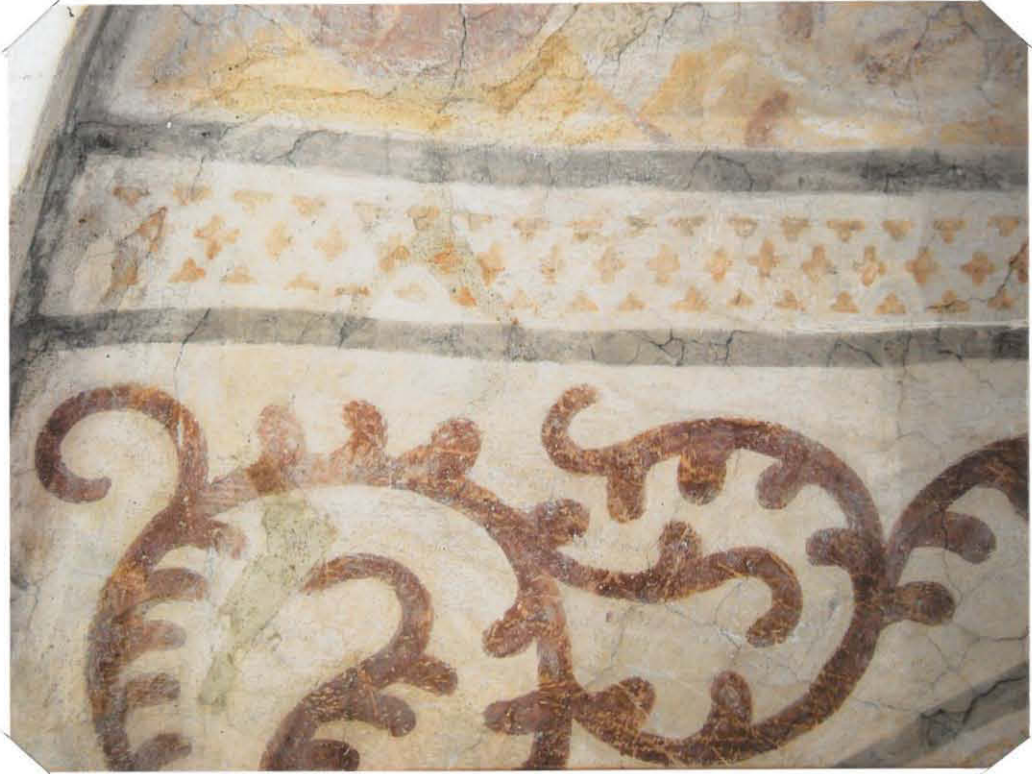
↑ AIKAISEMPIÄ PAIKKAUKSIA PUHOISTUKSEN VÄLK. ENNEN HÄIKYTYSTÄ
