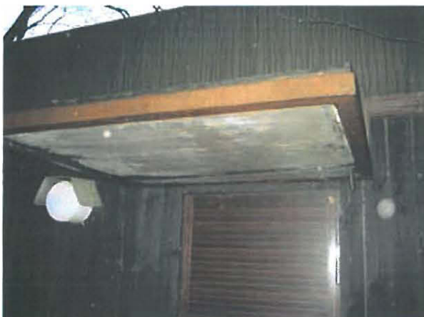
Sisäänkäynnin lippa ja alkuperäinen ulkovalaisin.
