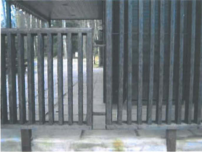
Lippukioskin yleisö-wc:n suojana oleva säleikkö.
