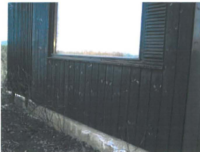
Eteläpäädyn betonisokkelissa on harmaita juovia. Pihkaiset oksanreiät erottuvat tummasta ulkuvuorauksesta eteläisillä sivuilla.
