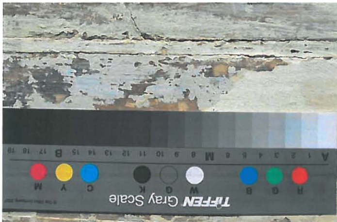
Kuvat 53 ja 54. Oikeanpuoleisen ikkunan F213 alakarmista paljastunut vaalean siniharmaa maalikerros (vas.) ja vasemman pystykarmin maali- ja tasoitekerroksia.
