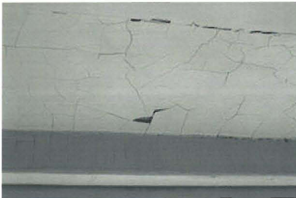
Kuva 25. Alakerran teehuoneen ikkuna F113. Yläikkunan yläkarmen kunto ennen konservointia.
