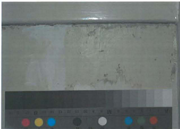
Kuva 73. Keittiön ja näyttelytilojen portaikon välisen oven KD106 peiliosasta paljastui kermansävyinen maalikerros.
