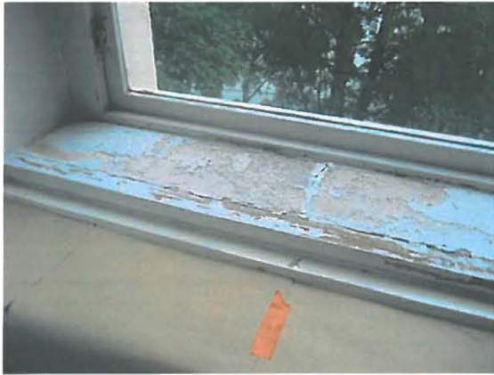
Kuva 30. Yläkerran makuuhuoneen ikkuna F215. Ennen.
