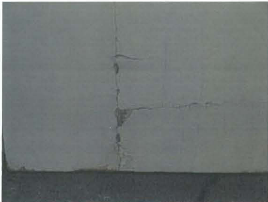
Kuva 32. Yläkerran kylpyhuoneen ovi KD212. Ennen.
