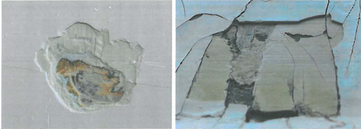
Kuvat 48 ja 49. Ikkuna F113. Yläaukon puitteen värikerroksia (vas.) ja yläaukon alakarmin värikerroksia (oik.)
