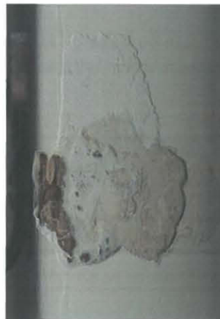
Kuvat 53 ja 54. Oikeanpuoleisen ikkunan F213 alakarmista paljastunut vaalean siniharmaa maalikerros (vas.) ja vasemman pystykarmin maali- ja tasoitekerroksia.
