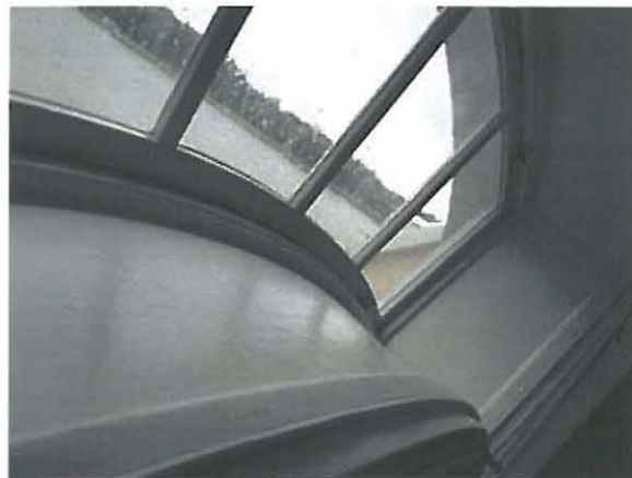
Kuva 20. Yläkerran ruokasalin ikkuna F213. Puhdistuksen jälkeen, ennen maalin kiinnitystä.
