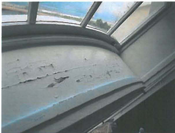
Kuva 20. Yläkerran ruokasalin ikkuna F213. Puhdistuksen jälkeen, ennen maalin kiinnitystä.
