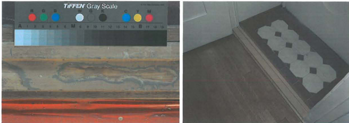
Kuvat 42 ja 43. Oven KD113 kynnyksen aiempia maalikerroksia (vas.) ja huoltomaalattu kynnykset valmiina (oik.)
