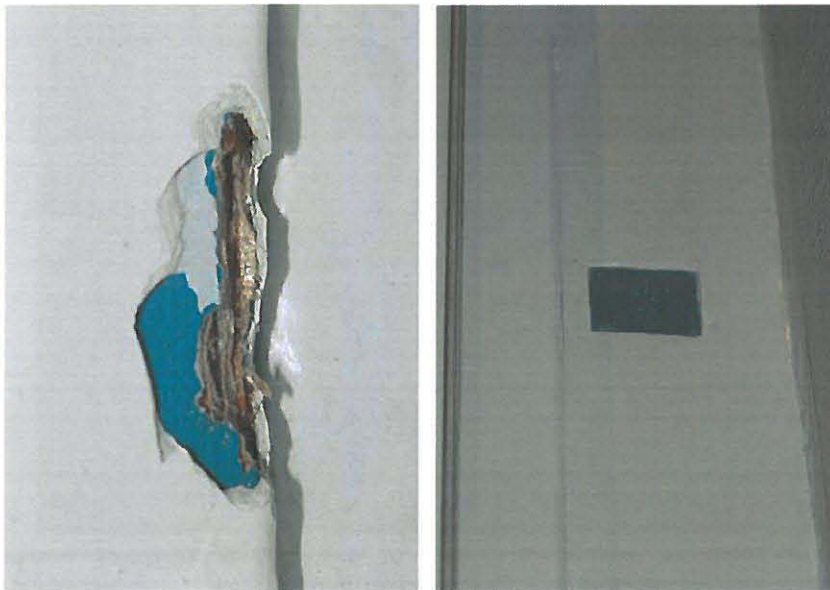
Kuvat 65 ja 66. Ikkunan F210 siniset maalikerrokset (vas.) ja ikkunan F211 karmiin esiin jätetty sininen maalikerros (oik.).
