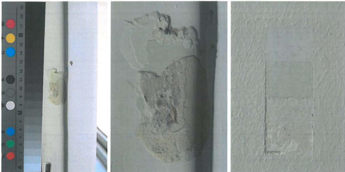
Kuvat 61 ja 62. Ikkunan F201 karmin maali- ja tasoitekerroksia (vas. ja kesk.). Oikeanpuoleisessa kuvassa makuuhuoneen (205) seinän väriportaikko, josta voi nähdä ikkunan olleen maalattu seinien kanssa samansävyyiseksi.
