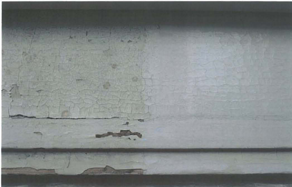
Kuva 29. Puhdistamattoman, kiinnittämättömän ja kittaamattoman pinnan sekä puhdistetun, kiinnitetyn ja kitatun pinnan rajakohta.
