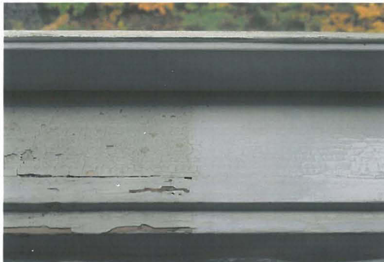
Kuva 2. Ikkuna F123. Rajakohta ennen ja jälkeen konservoinnin.
