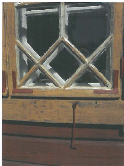
Kuva 16 Kalastajienmökin ikkuna puhdistettuna kitattuna ja ruosteenestomaalattuna
