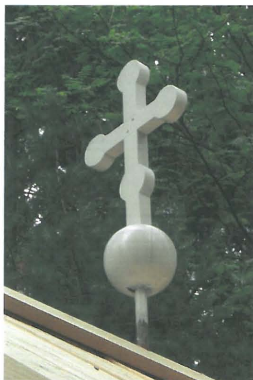
Kuva 14 Risti puhdistettuna ja maalattuna paikoillaan
