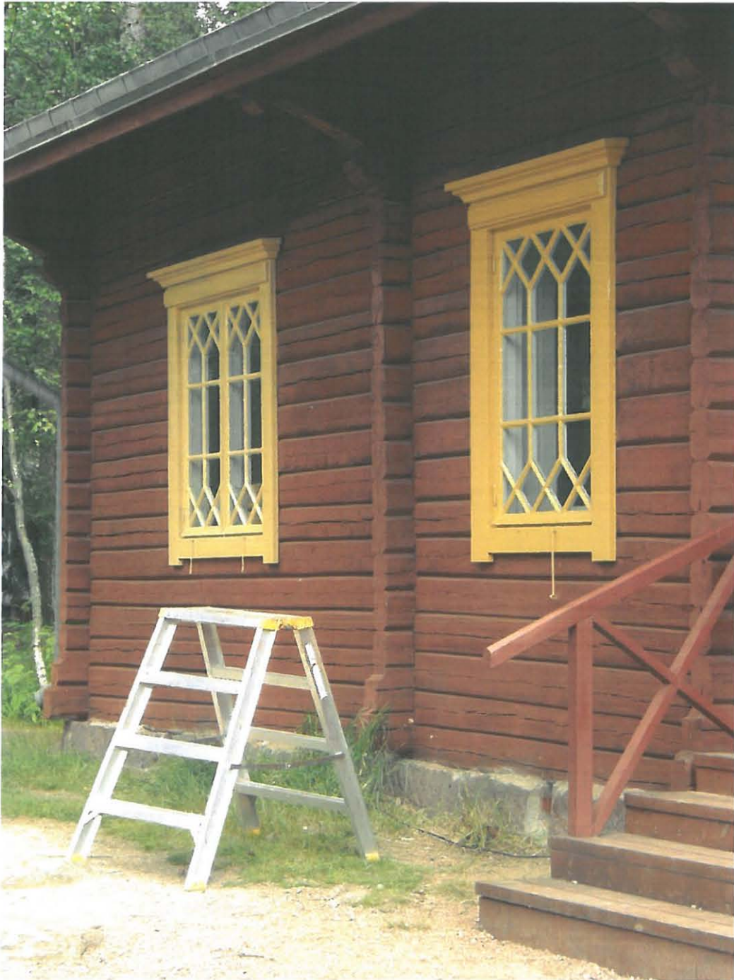
Kuva 17 Kalastajienmökki, oikeanpuoleinen ikkuna valmis, toisessa ensimmäisen maalauksen sävy
