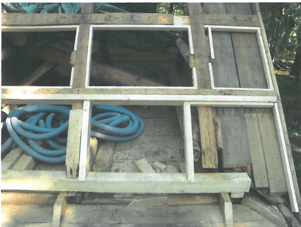
Kuva 6 Korjattua kattorakennetta kosken puolelta katsottuna
