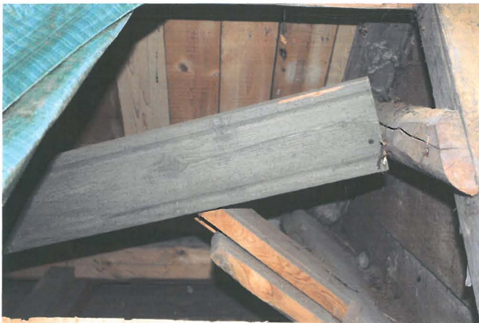
Kuva 5 Ristikkäistuki sekä etulipan yläosa(kuva: Jaana Ahonen)
