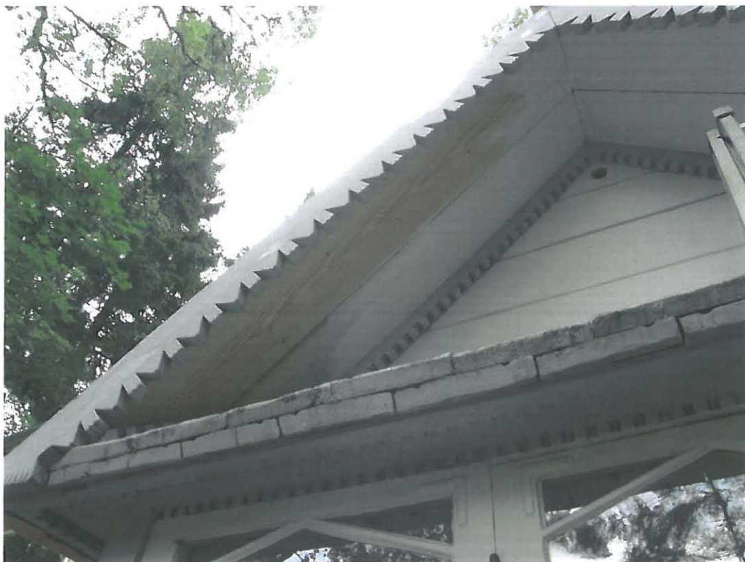
Kuva 9 Vaihdetut räystäänaluspuut ja tuuletusaukko
