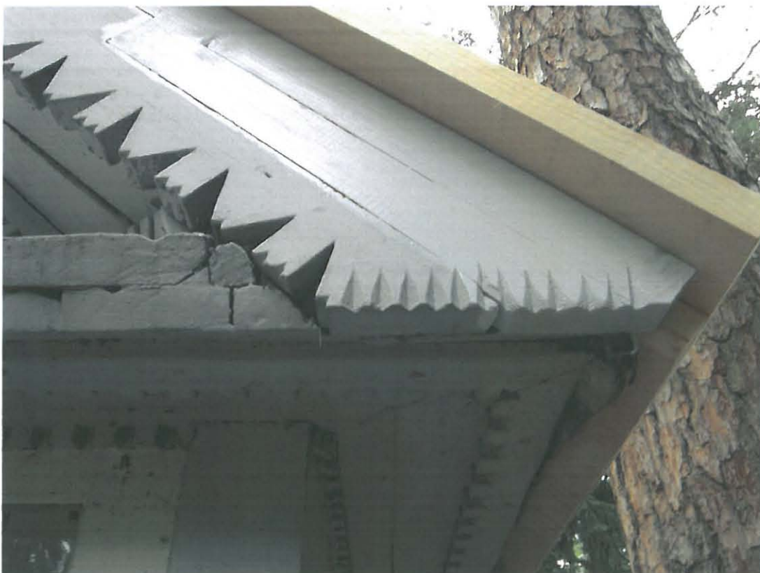
Kuva 10 Koristelistan paikkaus ja korotusrima ensimmäisen kerran maalattuna
