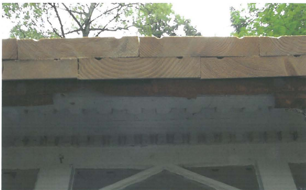
Kuva 8 Kaksi lautakerrosta räystään alta katsottuna
