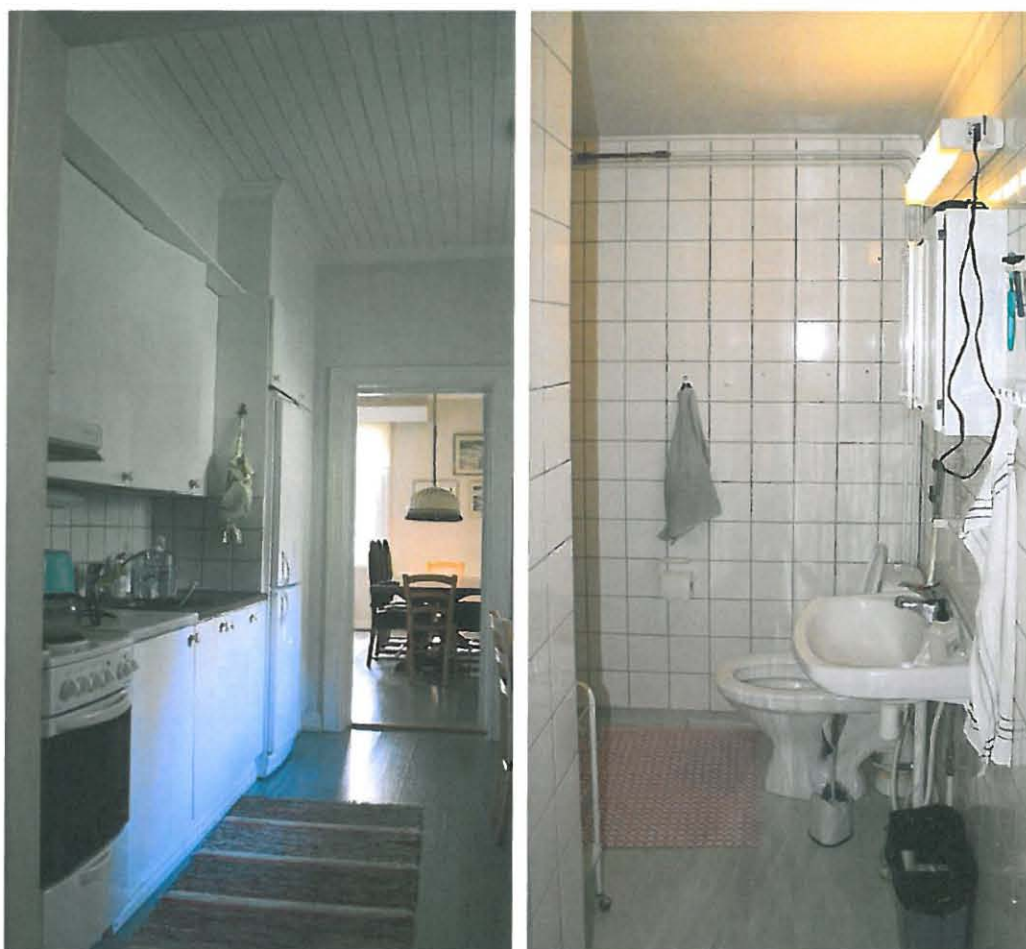
Kuva 19. Keittiö uusittiin kokonaan peruskorjauksen yhteydessä. Vanhasta keittiöstä lohkaistiin tilaa uudelle kylpyhuoneelle. (Jaana Ahonen 2010)
