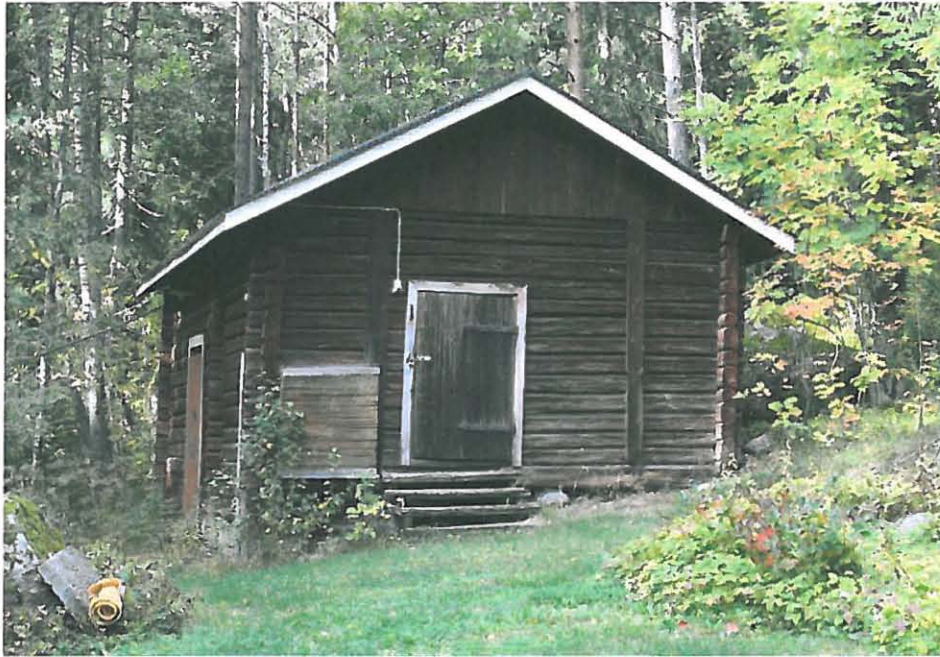
Kuva 23. Varastorakennuksen, jota on kutsuttu myös heinätalliksi, pädyssä on pieni kesäisin 1950- ja 1960-luvulla käytössä ollut nukkumatila. Rakennuksessa on pidetty myös eläimiä. (Jaana Ahonen 2010)
