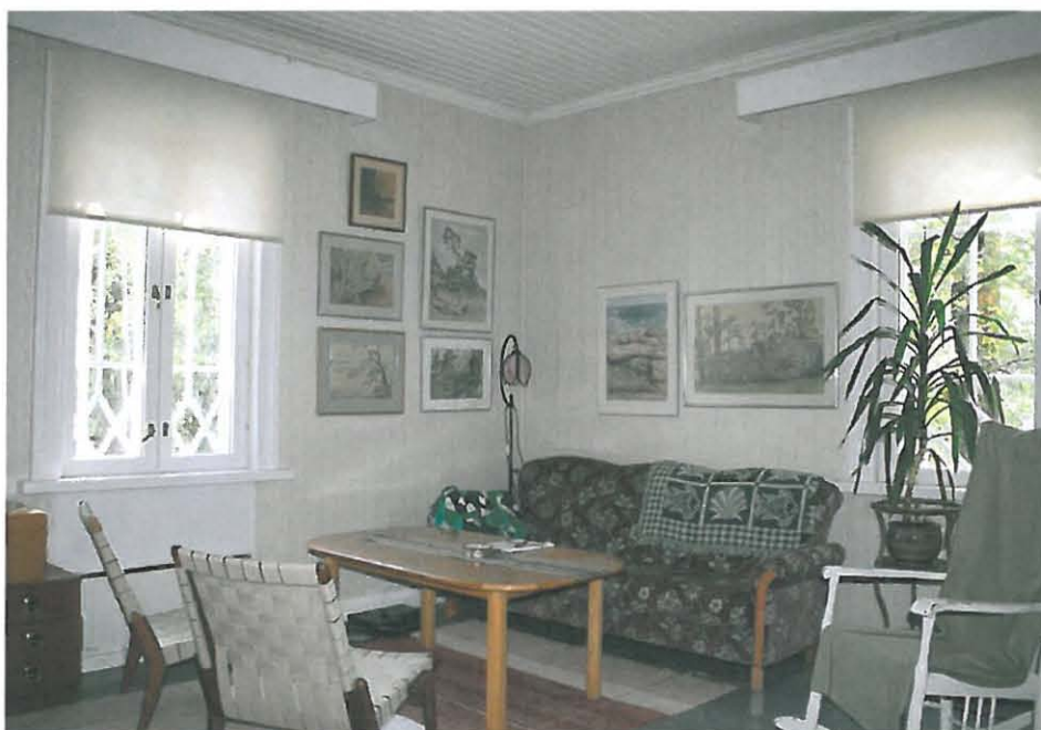
Kuva 16. Näkymä olohuoneesta. Vanhat sisäpuitteet uusittiin peruskorjauksen yhteydessä uusilla kaksilasisilla ikkunaelementeillä. Huoneisiin asennettiin myös 1980-luvulle tyypilliset verhokotelot. (Jaana Ahonen 2010)
