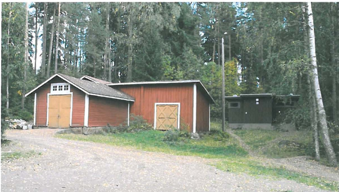
Kuva 24. Talli- ja vaunuvaja sekä 1969 rakennettu käymälärakennus. (Jaana Ahonen 2010)
