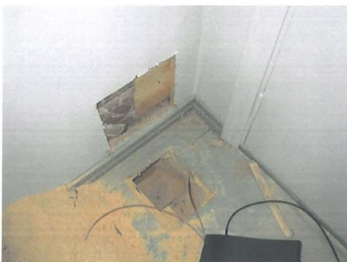
Kuva 15. Tp 2. Lattia Tp 3. Ulkoseinä
