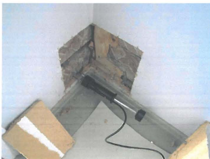
Kuva 14. Tp 2. Ulkoseinä Tp 1. Väliseinä
