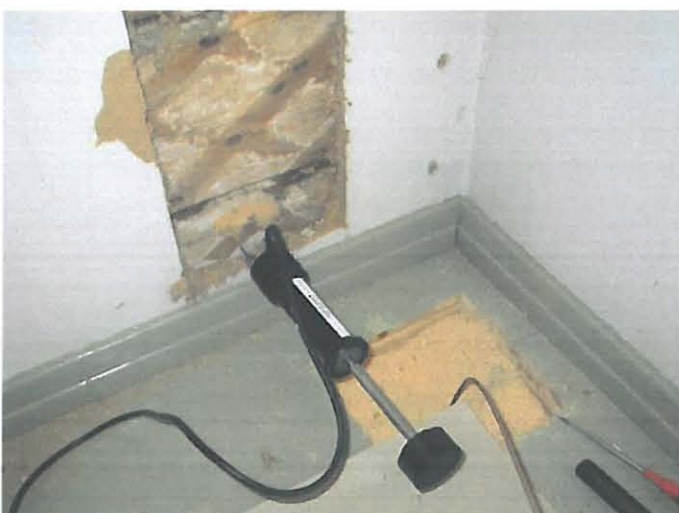
Kuva 12. Tp 1. Lattia, ulkoseinä
