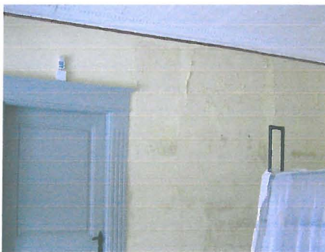
Lipunmyynti huoneen seinäpintaa ennen restaurointia
