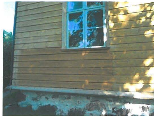
Paikkaukseen käytetty valmis keittomaali on pysynyt hyvin.
