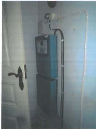
Sähkö- ja turva-asennukset eteisessä.
