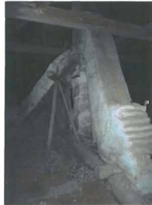
Useita hormoneja on ollut liitettynä samaan piippuun. Hormit on katkaistu
