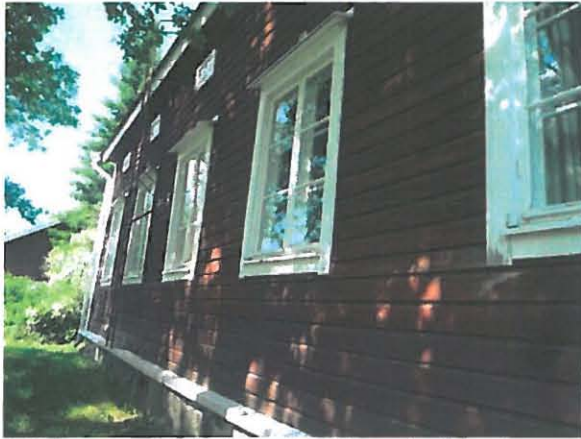
Julkisivun punamultakeittomaali on hieman haalistunut.
