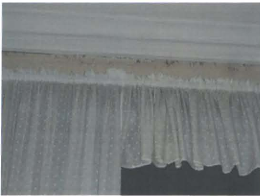
Huone 13. Keltainen Sali. Listan alta valuvat roskat voivat olla merkki vauriosta.
