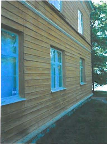
Ulkovuoraus on ehjä, mutta paikalla keitetty keltaokra keittomaali epäonnistui.
