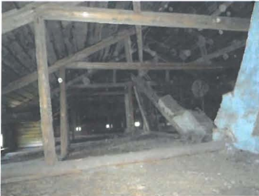
Kattorakenteet ovat ehjät ja ullakko siisti.
