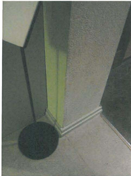
Kuva 5. Kuluma paikkauksen jälkeen.
