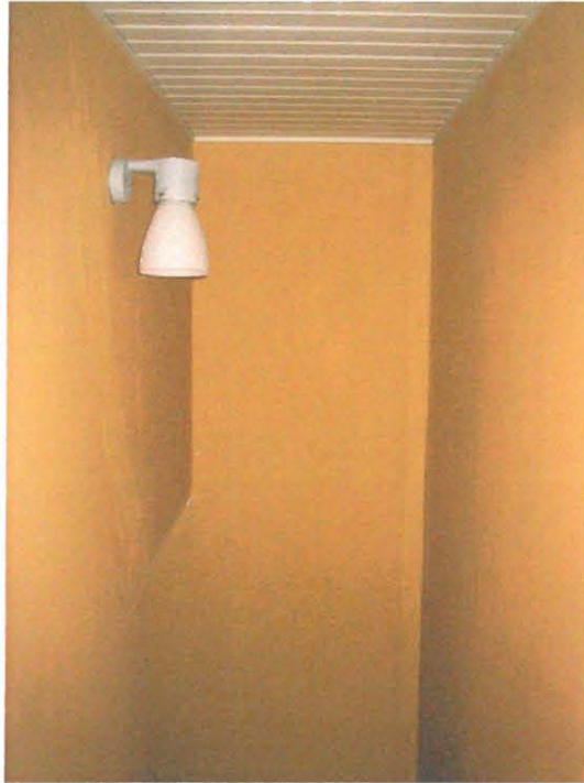
Kuva 9. Repeämät paikattuna ja seinät maalattuna.
