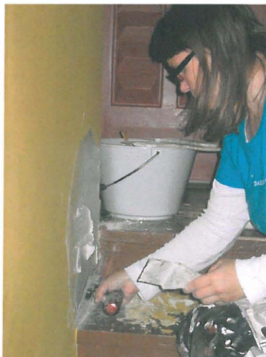
Kuva 7. Kolojen täyttö Polyfillalla.
