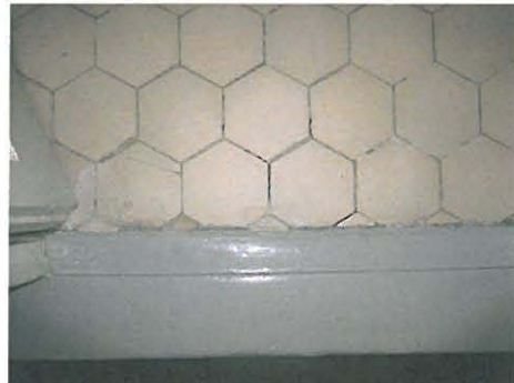
Kuva 18. Lattiakaakeli retusoinnin jälkeen ja jalkalista maalattuna.
