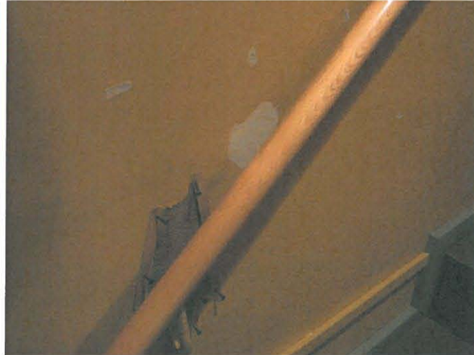
Kuva 11. Pieniä repeämiä ja reikiä paikattuna.
