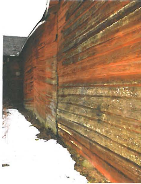
Aittapään pullistunutta hirsiseinää ja sen jatkeena olevaa väliosan piirurunkoista, laudoitettua seinää.
