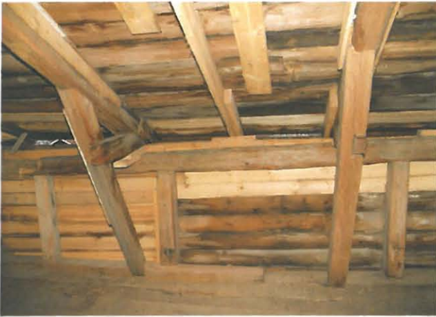
Väliosassa on kattotuolit, joiden kontit nojaavat vaakaparruun välipohjan kohdalla.
