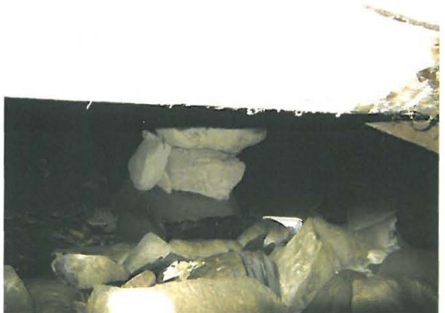
Lattian kannattajia on tuettu kivilatomuksilla.
