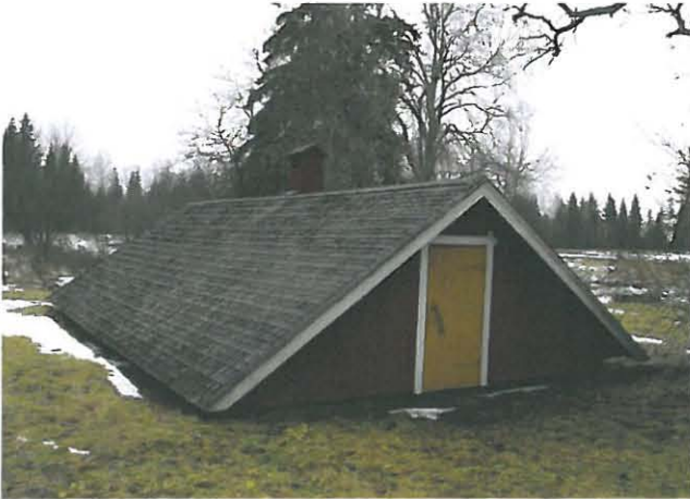
Kellarin katosrakenne. Pärekatot ovat huonokuntoiset, laudoitetut päädyt ovat kunnossa.
