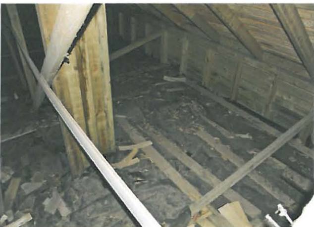
Kellarin suojakatoksen rakenteita. Seinän runko ja mahdollisesti laudoituskin ovat painekyllästettyä puuta. Välikatto on puurakenteinen (kellarissa ei ole kiviholvia).
