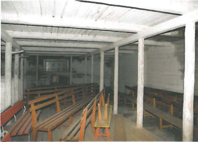
Tallin 105 välikattoa tukevat parrut ja pilaririvit.
