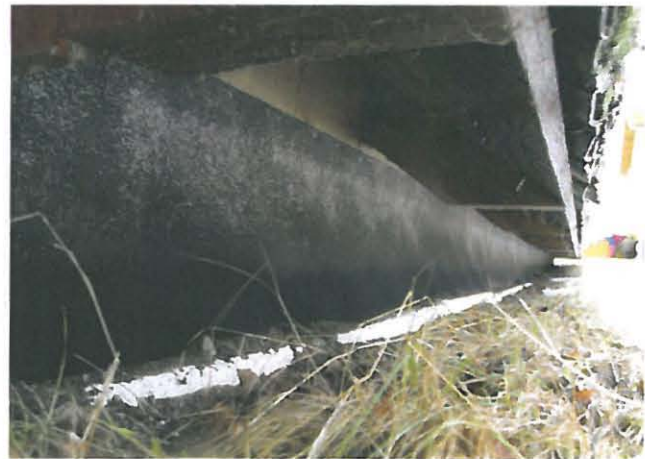
Kellarin seinä on suojattu bitumihuovalla.
