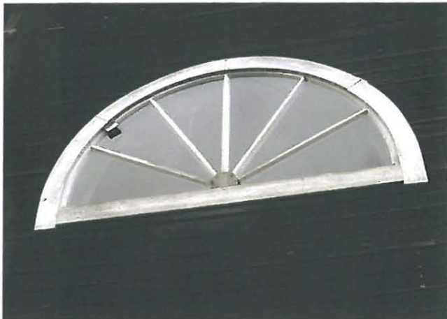
Päätyjen lunetti-ikkunat uusittiin 1970-luvun korjauksessa.
