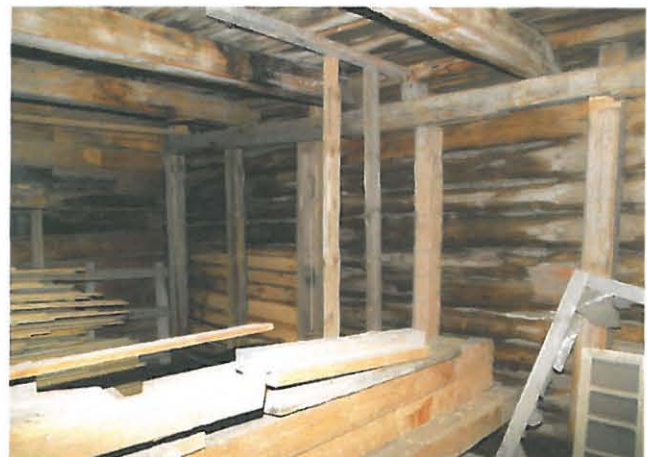
Väliosan piirurunkoa. Välipohja on tuettu ulkoseinillä tolppien päälle asetetulla vaakaparrulla. Varasto 103.
