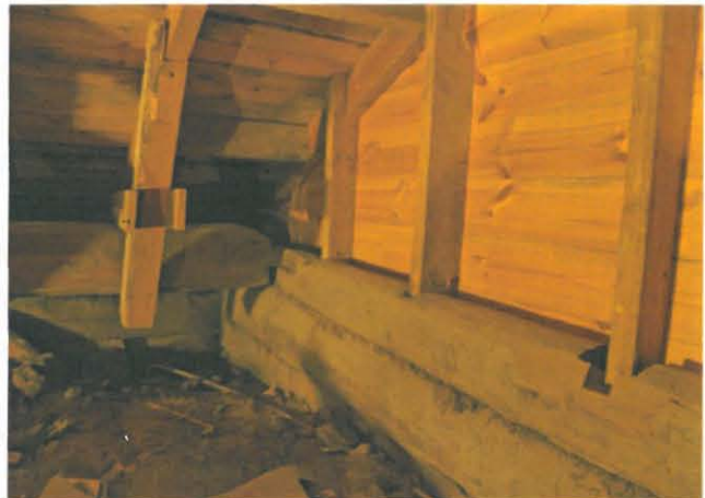
Rakennuksen hirsirunkoa koillispäädyssä. Kattotuolien jalasparruna on hirsi aiemmasta päätykolmiosta.
