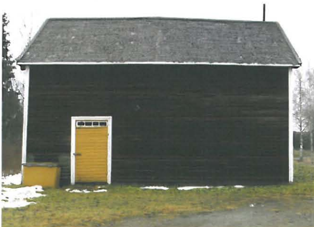
Tallin kaakkoisseinää. Keskiosassa on säilynyt alkuperäinen laudoitus.
