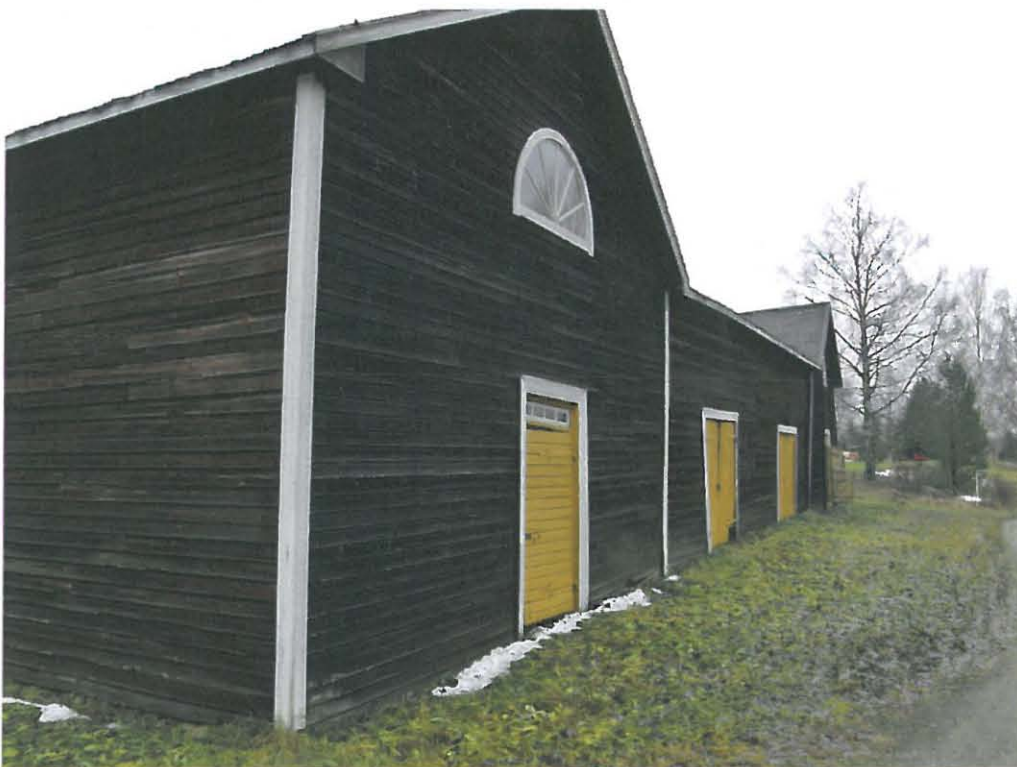
Koitsanlahden hovin kaksi keskeistä rakennusta, päärakennus ja talli. Kuntoarvio keskittyy näihin rakennuksiin.
