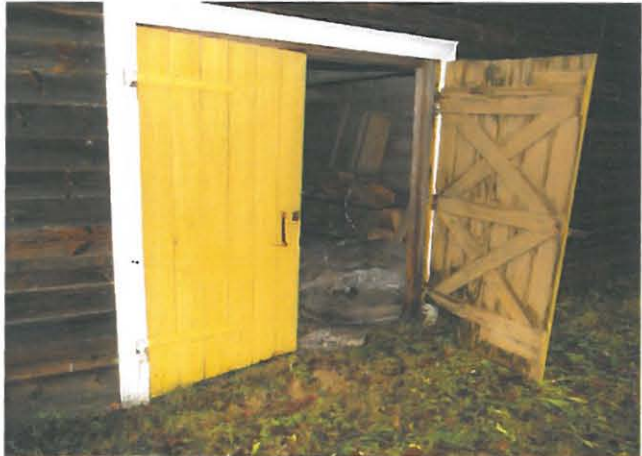
Varaston lautarakenteinen pariovi.
