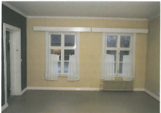
Vahtimestarin asunnon huoneiden seinät ja katot on levytetty, latioissa on betonilaatan päälle tehty levylattia ja muovimatot.
