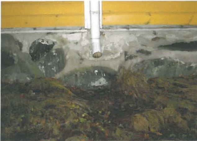
Rakennuksen luonnonkivistä muurattua kivijalkaa. Sokkeliä on aikojen myötä paikattu sementtillaastilla.
