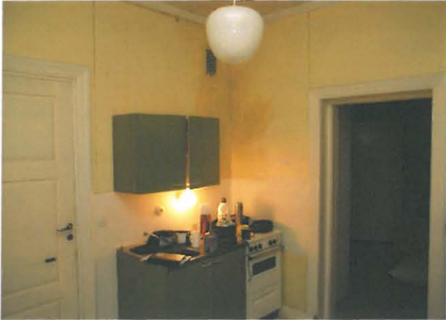
Keittiön vaatimaton varustus ja 1960-luvun sähköasennuksia. (huone 101)
