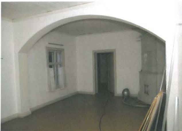
Huone 106 on aikoinaan muodostettu yhdistämällä kaksi pienempää huonetta hirsiseinään tehdyllä kaariaukolla.
