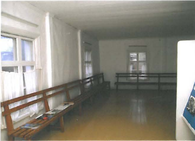
Salin pullistuneita hirsiseiniä on sisäpuolelta tuettu följareilla. Seinissä on pinkopahvit ja katossa vanha laudoitus. Lattia uusittiin lahovauriotten takia 1984. (huone 114)
