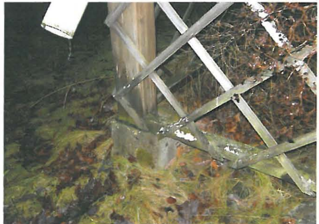
Lasikuistin nurkan betoniperustus ja kantava puutolppa.
