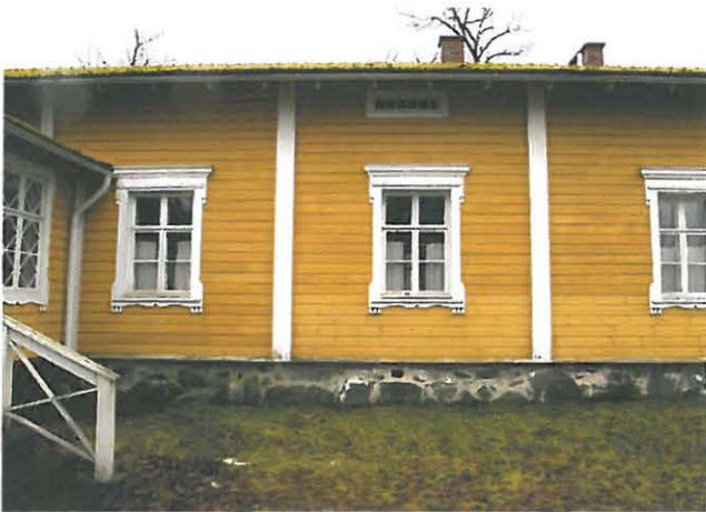
Rakennuksen kaakkoissivua. Julkisivulaudoitus on hyväkuntoinen.
