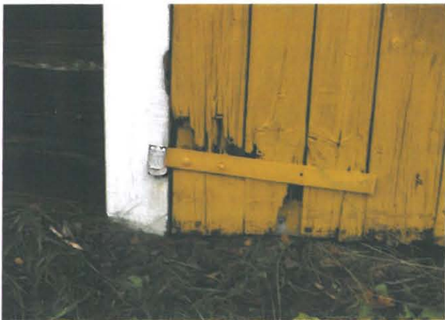
Etenkin ovien alaosissa on kosteuden aiheuttamia vaurioita. Oikealla tallin kaksiosainen ovi (ylä- ja alaosat ovat alunperin aenneet erikseen).
