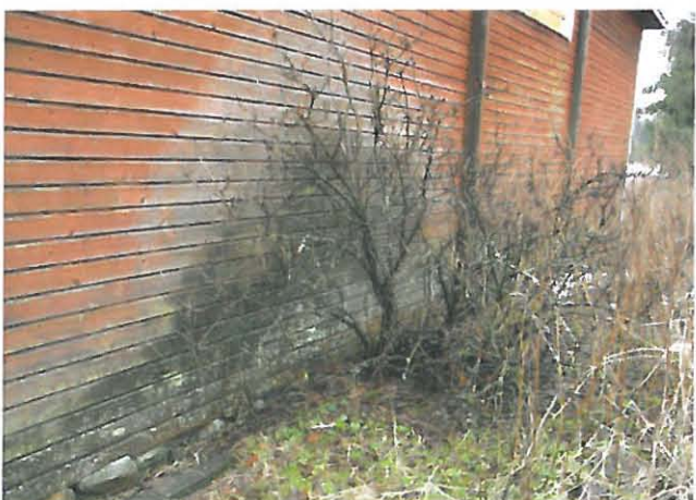
Seinänvierillä olevat pensaat olisi poistettava ja maanpintoja alennettava.
