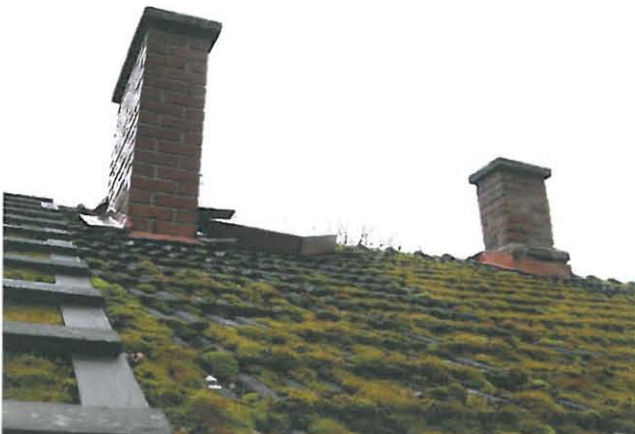
Ainoat piiput ovat rakennuksen koillispuolella, muutoin vanhat savuopiiput on purettu. Vasemmalla 1960-luvulla muurattu keskuslämmityskattilan piippu, sen vieressä kattoluukku. Oikeanpuoleinen vanhempi piippu on säilytetty ilmeisesti ilmanvaihtohormeina.
