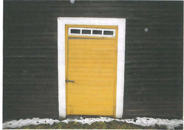
Koko rakennuksen runko on kokenut muodonmuutoksia, jotka näkyvät esim. ovien karmeissa.
