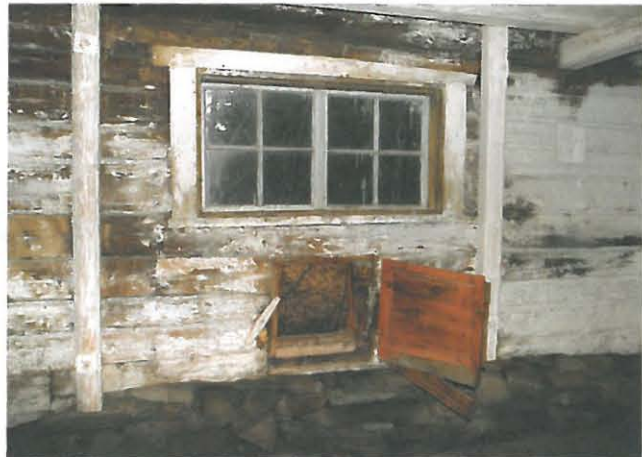
Tallin ikkuna ja lantaluukku.
