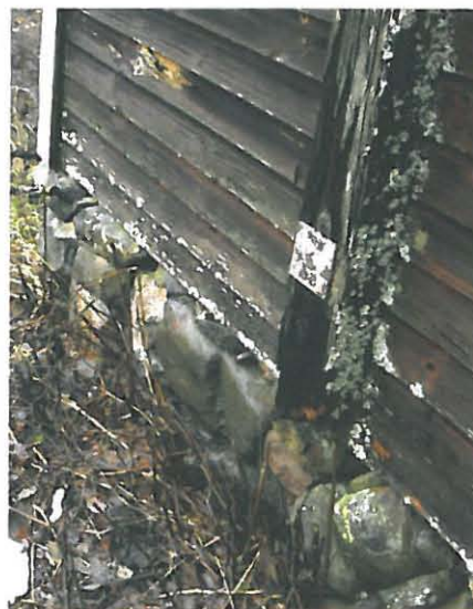
Aittapään hirsirungon nurkka varaston 103 puolelta. Ulkoseinää on tuettu lisäpiiruilla jo aiemmissa korjauksissa.
