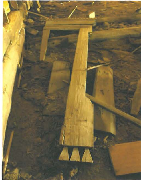
Ullakolla on säilynyt osian vanhoista vuorilau-doista.
