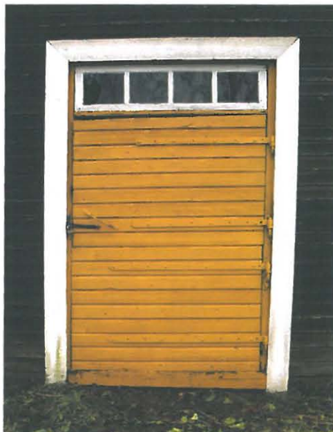
Etenkin ovien alaosissa on kosteuden aiheuttamia vaurioita. Oikealla tallin kaksiosainen ovi (ylä- ja alaosat ovat alunperin aenneet erikseen).
