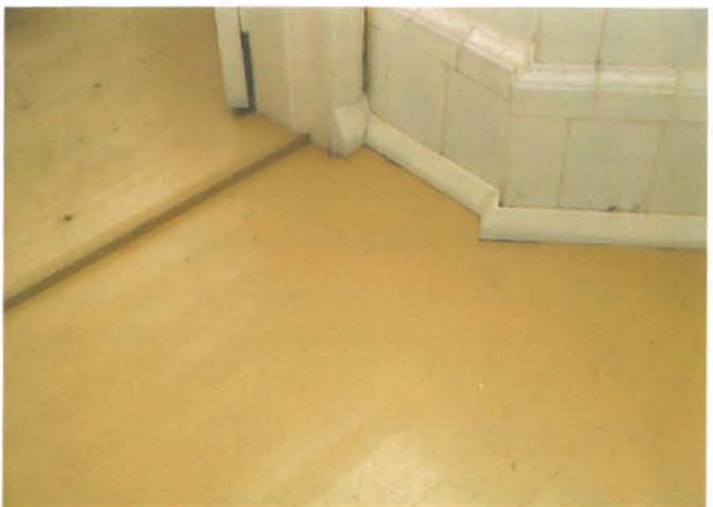
Salin uusittu lautalattia, viereisessä huoneessa näkyy vanhaa laudoitusta.
