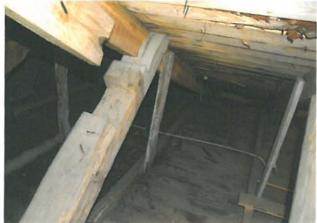
Lasikuistin kattorakenteissa on säilynyt osa vanhaa kattotuolia, jonka pää on muotoiltu.
