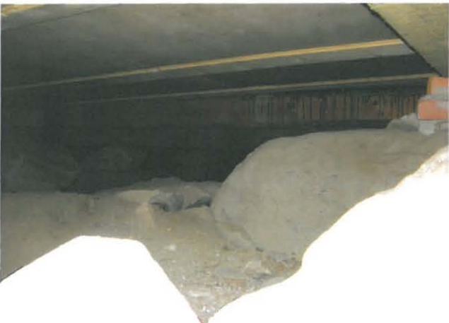
Rakennuksen alustaa salin 114 kohdalla. Maapohja on kuiva ja kivinen.
