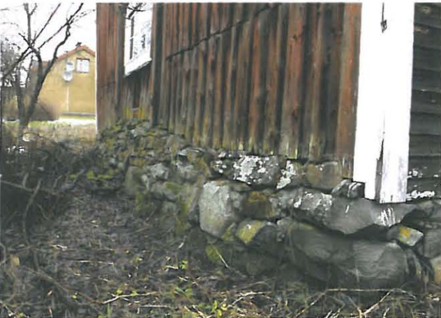
Kivijalkaa tallin päädyssä - ainut osa rakennusta, jossa perustus on selvästi maanpinnan yläpuolella.
