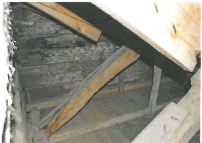
Lasikuistin ullakolla näkyy hirsiseinää, joka on joskus ollut rapattu.
