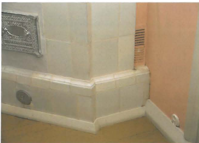
Ilmalämmityksen sisäänpuhallusventtiilit on monissa huoneissa sijoitettu uunien taakse, poistosäleiköt ovat puolestaan kattopinnoissa. Ilmalämmitys on todennäköisesti mitoitettu vain museotilojen peruslämpöä ja kuivatusta varten.
