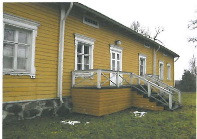
Luoteissivun 1980-luvun lopulla uusittu terassi.
