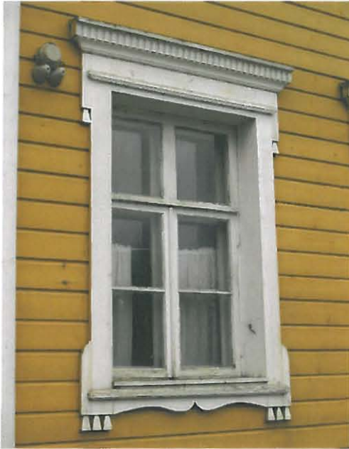
Suurin osa ikkunoista on uusittu 1960-luvulla, mutta vuorilaudat ovat vanhat.
