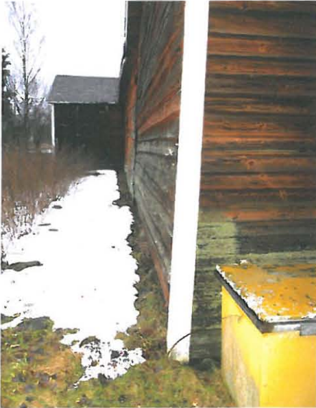
Aittapäässä luoteisseinä on hirsipinnalla, muut on laudoitettu. Hirsiseinä on alaosaltaan laho ja pahasti pullistunut.
