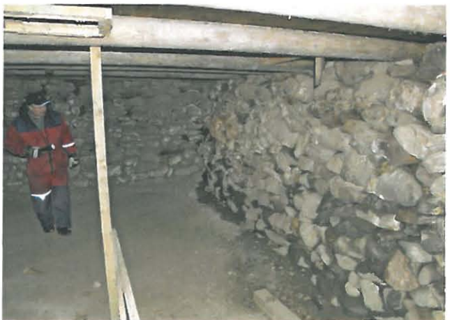
Kellarin seinät on ladottu pienehköistä peltokivistä. Pohjois-sivulla kivimuri on pullistunut sisäänpäin ja pintavesiä valuu kellarin.
