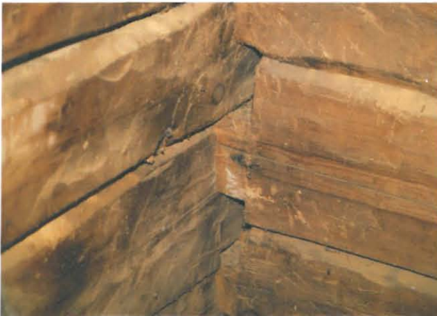
Työkaluvaraston hirsiseinän alaosassa ulkonurkat ovat auneet salvoksistaan.
