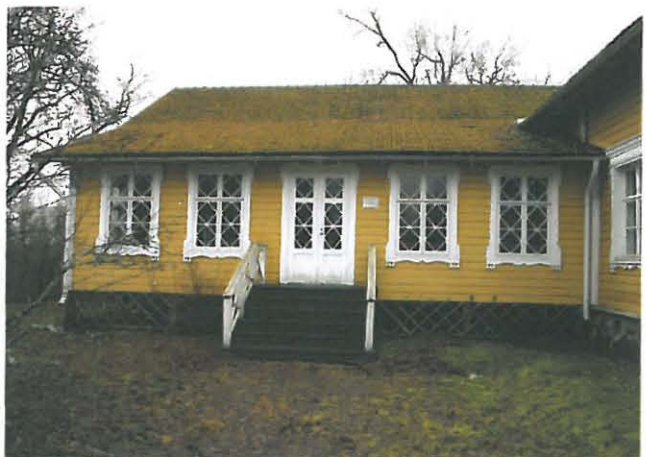
Lasikuistin 1960-luvulla uusitut ikkunat, jotka tehtiin ilmeisesti vanhan mallin mukaan.
