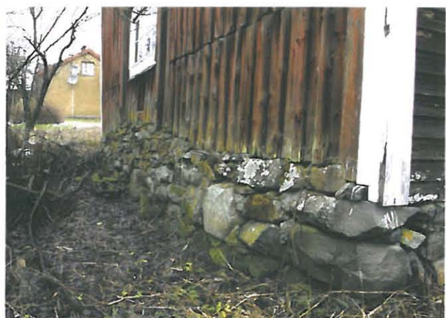
Tallin luoteisseinässä on vanha pysty-laudoitus.
