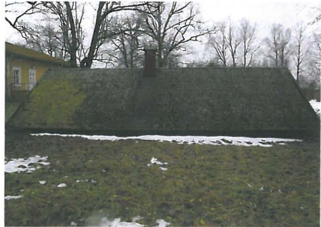
Kellarin katosrakenne. Pärekatot ovat huonokuntoiset, laudoitetut päädyt ovat kunnossa.
