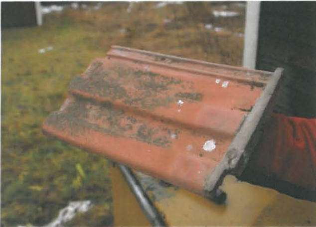
Kattamisessa käytetyt sementtitiilet ovat yleistä, 1930-luvulta lähtien käytettyä tyyppiä. Paikkatiiliä säilytetään tallirakennuksessa.
