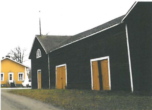
Tallin kaakkoisseinää. Keskiosassa on säilynyt alkuperäinen laudoitus.
