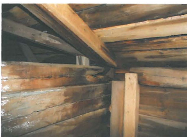
Aittapään hirsirungon nurkka varaston 103 puolelta. Ulkoseinää on tuettu lisäpiiruilla jo aiemmissa korjauksissa.
