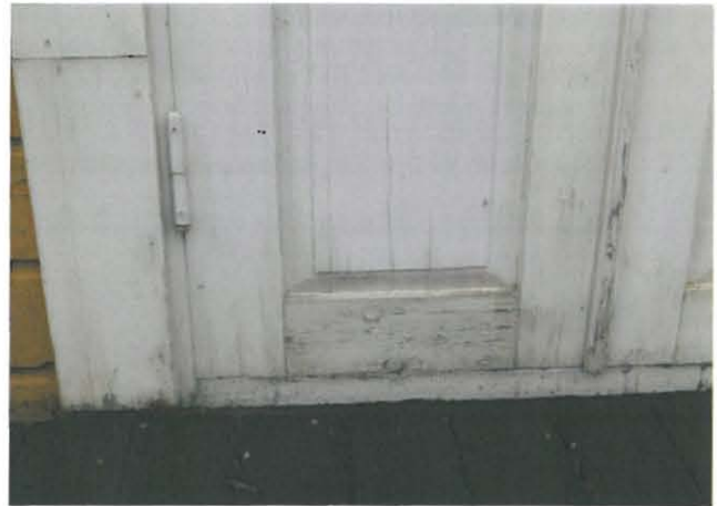
Kaikki ulko-ovet olivat pahastui turvoksissa määrän kesän ja syksyn jälkeen (lasikuistin ovi).
