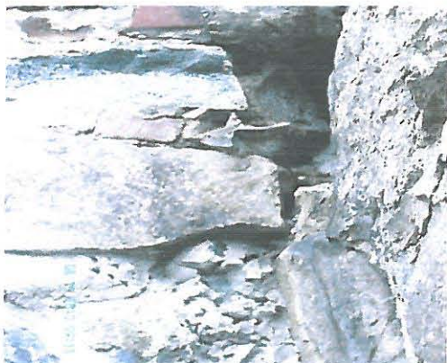
KUVA 9. Ylhäällä on tyhjä onkalo.
