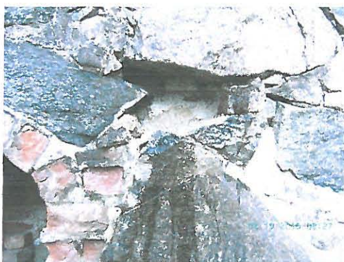
KUVA 13. Kiilakiven jättämä aukko.
