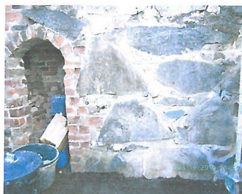
KUVA 14. Korvaava kivi on paikallaan.
