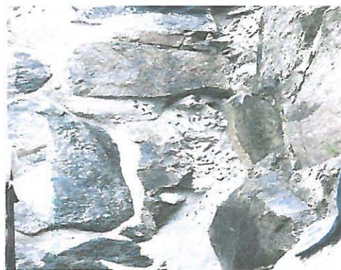
KUVA 8. Muuria edetään ylöspäin, täyttämällä se vaiheittain laastilla ja kivillä.
