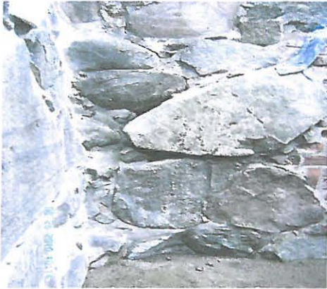
KUVA 26. Alhaalla olevan kiven taakse juotettiin laastia.
