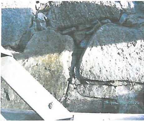
KUVA 20. Täytekiviä on muurattu jokaisen muurikiven ympärille.
