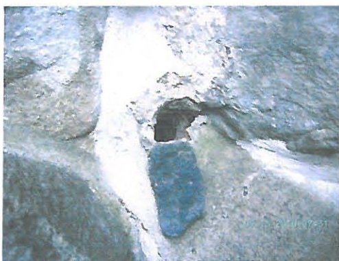
KUVA 7. Nurkkaus täytetään ensin juottamalla sinne ohutta laastia.
