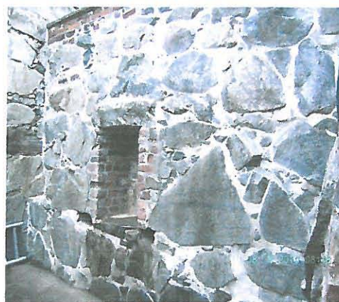
KUVA 12. Restauroitu itämuuri. Tumma kohta keskellä alhaalla on märkä.
