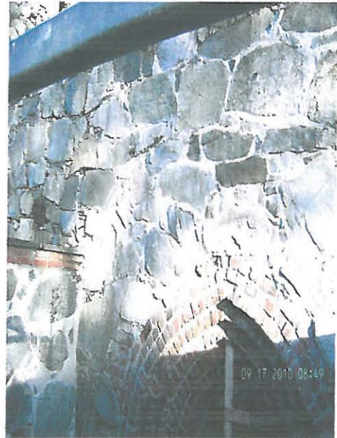
KUVA 25. Pohjoismuurin yläosa saumattuna.
