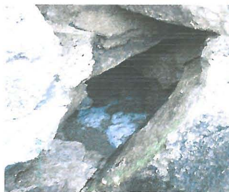
KUVA 16. Näin syvän onkalon täyttö suoritetaan asteittain laastilla ja kivillä.
