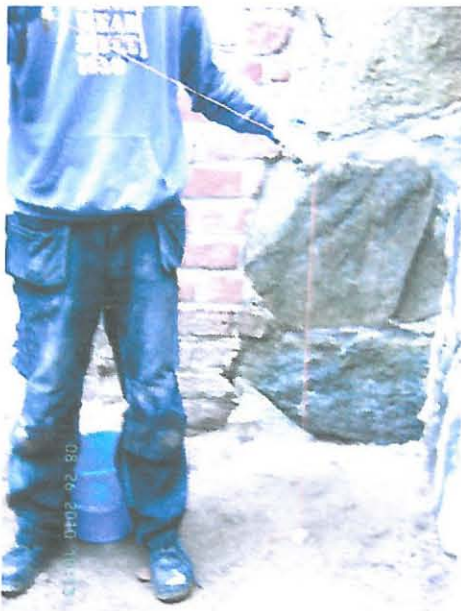
KUVA 28. Kuvassa näkyy kiven takana olevan onkalon vähimmäissyvyys.
