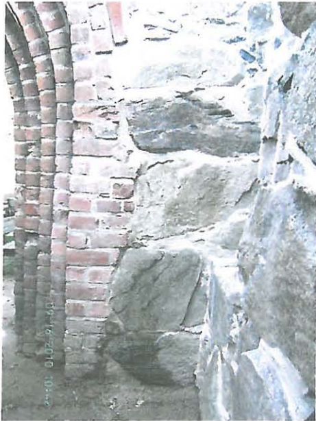
KUVA 24. Pohjoismuurin alaosa saumattuna.
