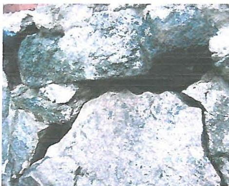
KUVA 15. Sauma avataan reippaasti. Puhdistetaan irtonaisesta aineksesta ja huuhdellaan hyvin.
