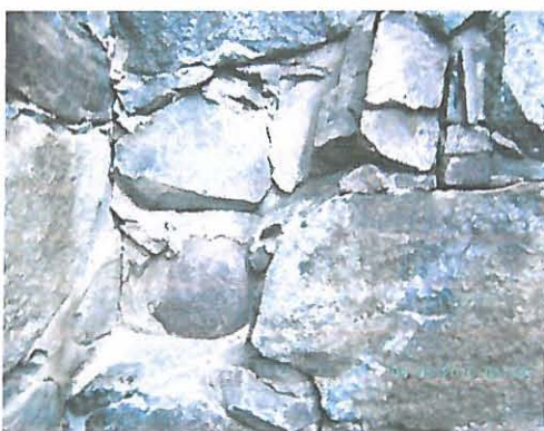
KUVA 1. Ylisauhaus ja irtonaiset saumat saavat muurit näyttämään todella ankeilta.
