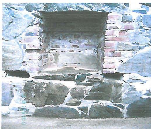
KUVA 11. Itämuurin komeron pari pahiten vaurioitunutta tiiltä uusitaan.
