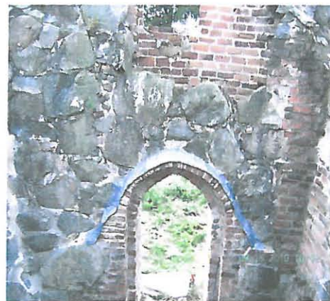
KUVA 29. Etelämuurin restaurointia jatketaan ensi kesänä. Nyt edetään lyijylevyn alkamisen korkeudelle.
